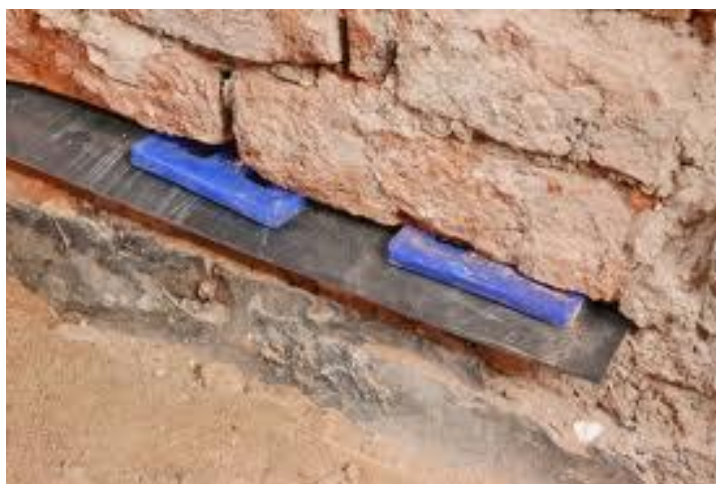
Ukázka zatlučení klínů do spáry
