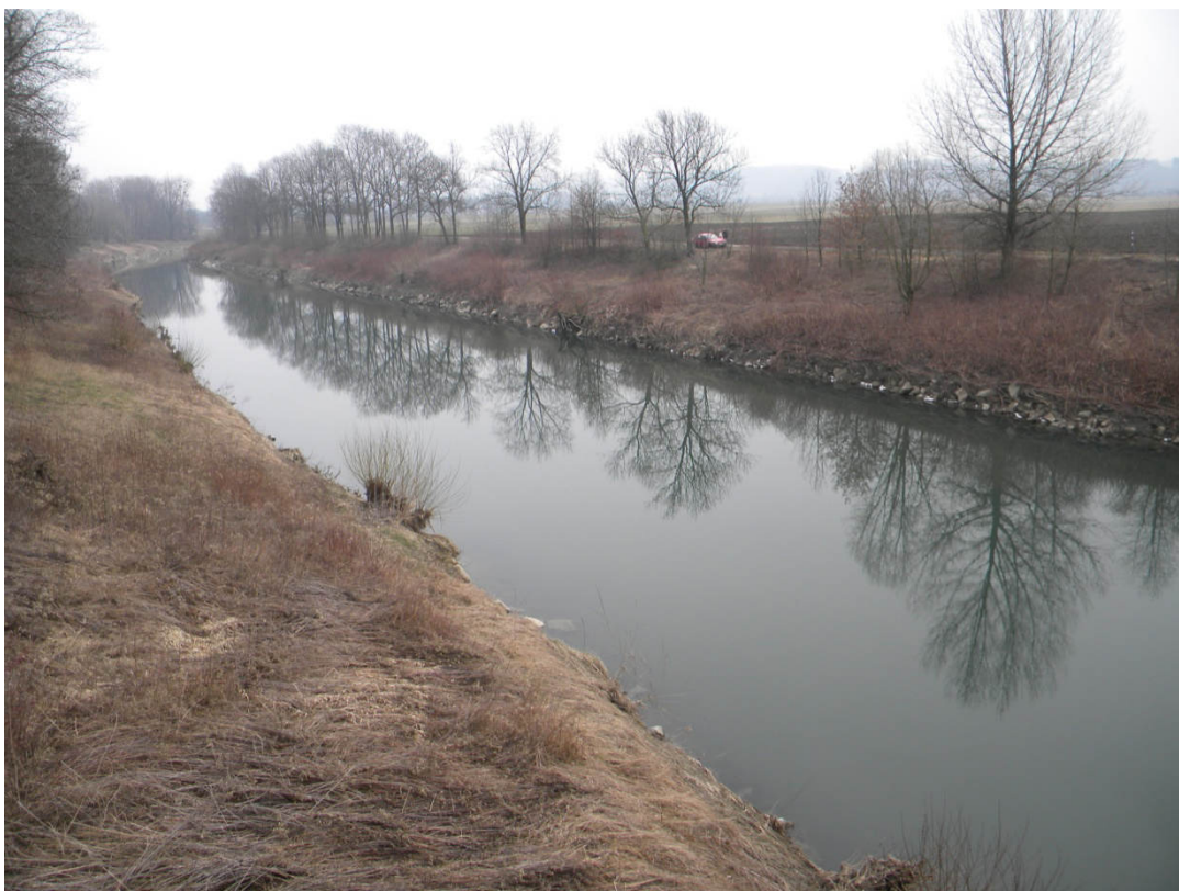
Obr. 4 ZÚ Km 22,791: Pohled od silničního mostu Osek proti směru proudění
