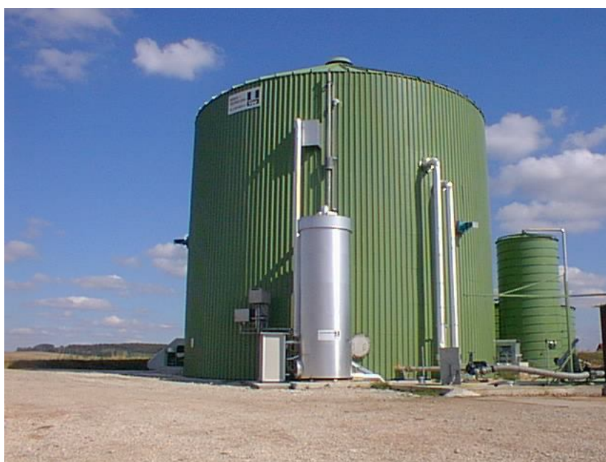
Obr. 5-4 Anaerobní reaktor (fermentor) [6]
