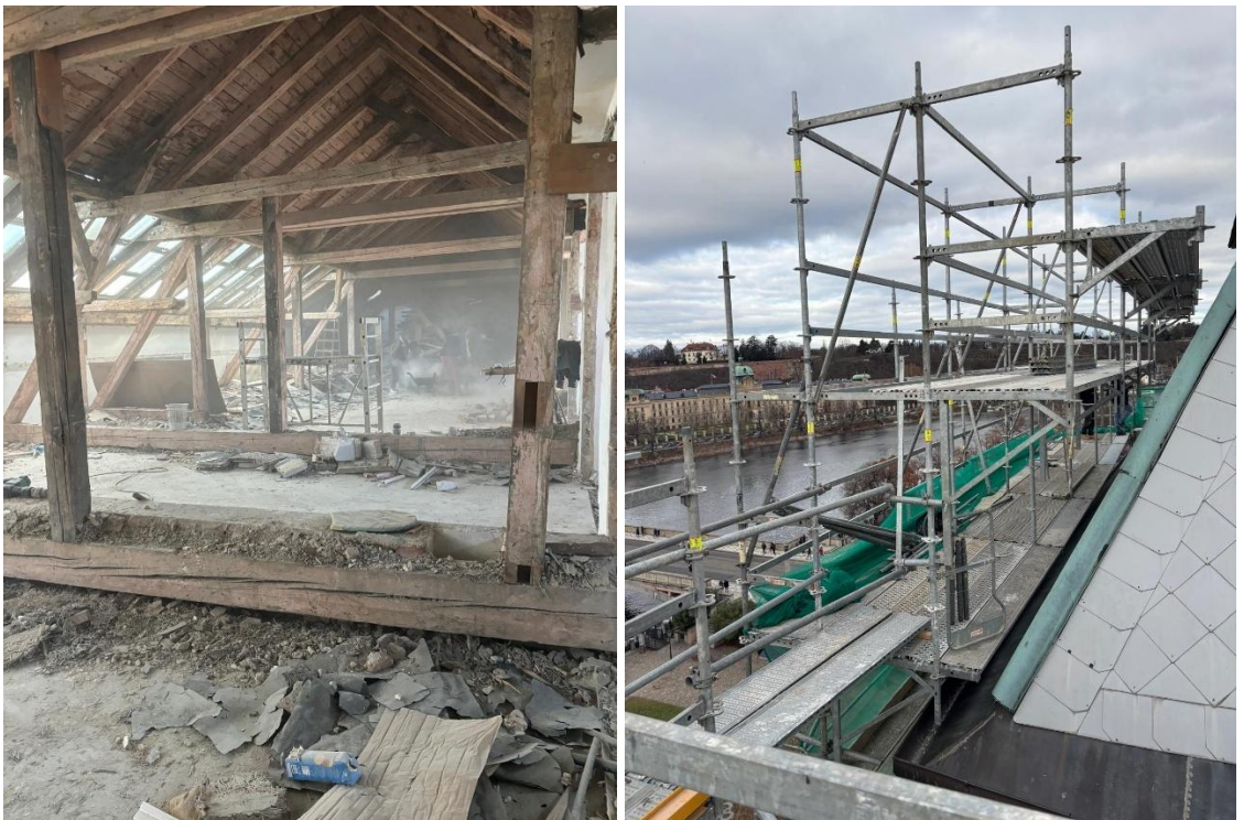
Obrázek č. 12 a 13: Fotodokumentace průběhu stavební zakázky. [zdroj vlastní]
