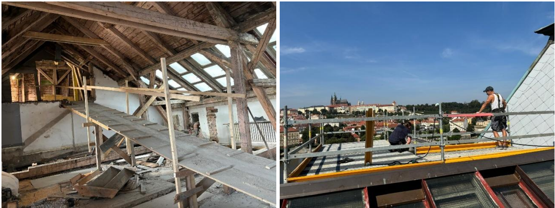
Obrázek č. 10 a 11: Fotodokumentace průběhu stavební zakázky. [zdroj vlastní]
