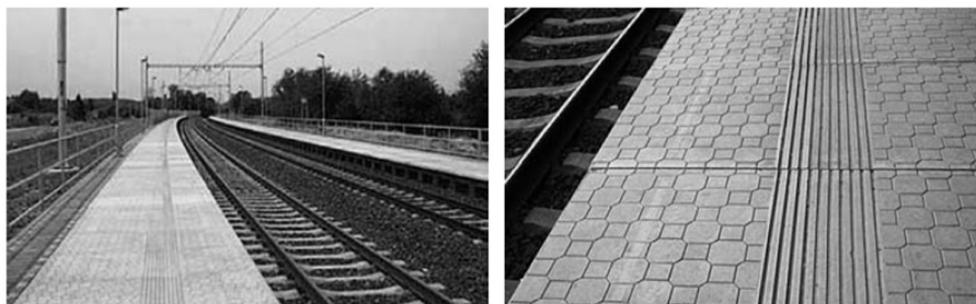
Obrázek 19 - Vodicí linie s funkcí varovného pásu
