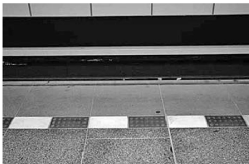
Obrázek 18 - Varovný pás na speciální dráze
