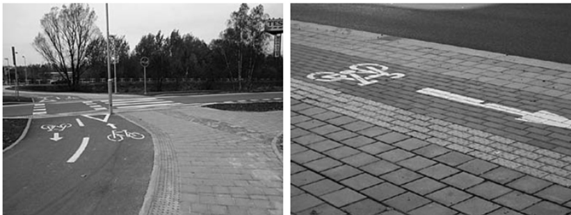
Obrázek 17 - Hmatný pás rozdělující cyklistickou stezku a chodník
