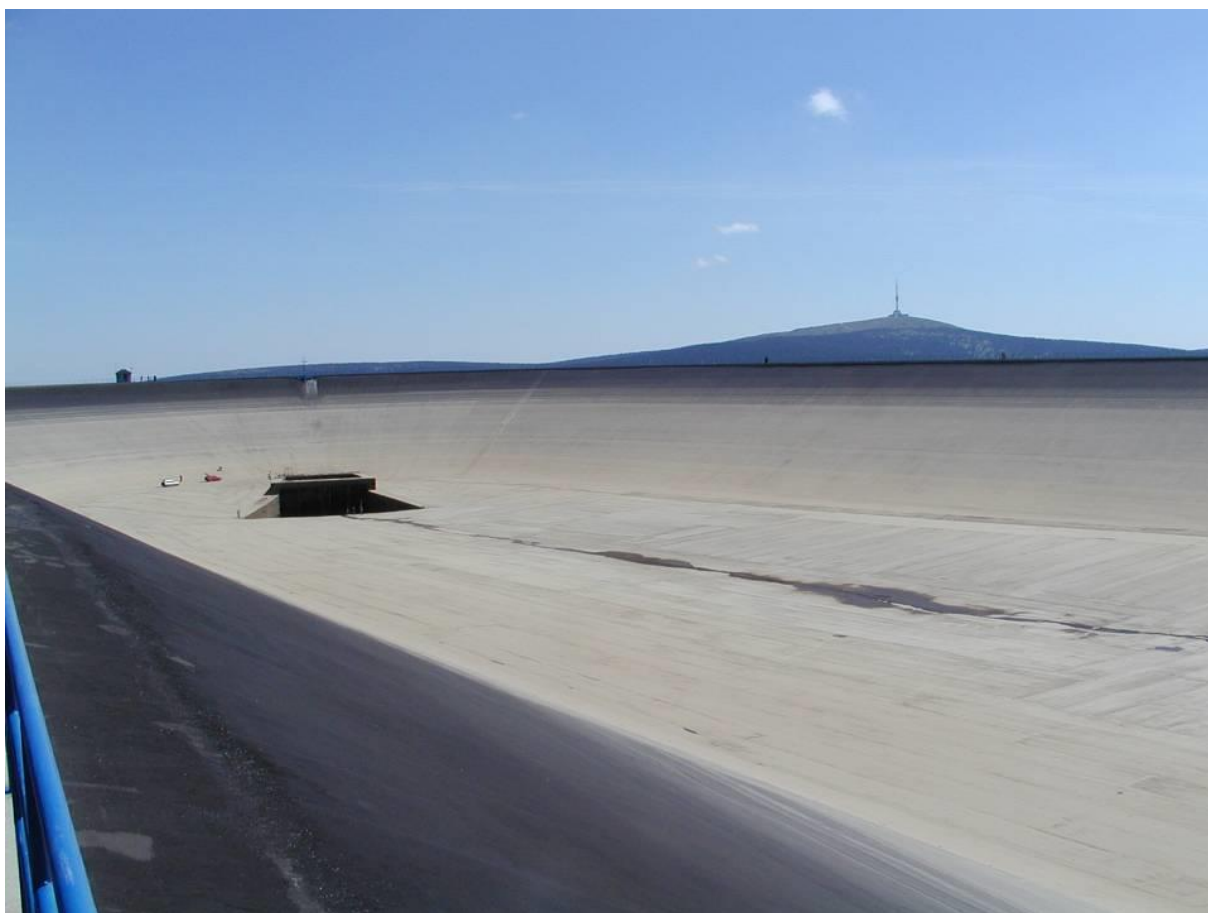
Obr. 6) Asfaltobetonové těsnění na PVE Dlouhé Stráně [18]
