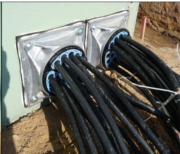
Obr. 2.5 Osazené kabely v průchodce
