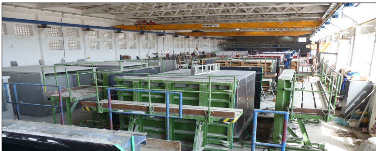
Obr. 7.2 Výroba betonových skeletů
