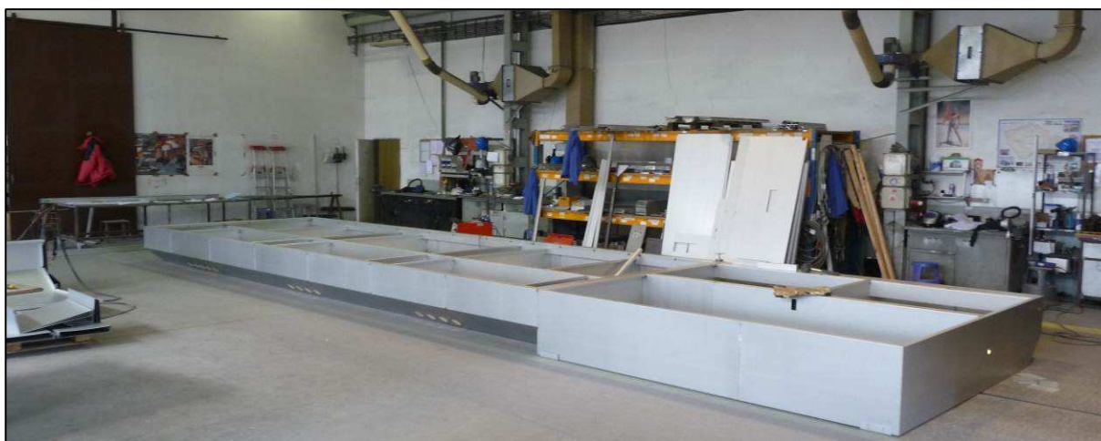
Obr. 7.1 Sestavování základu aluzinkové trafostanice
