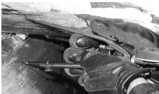
Obr. 4.9 Práce se srubařským kružítkem [14]
