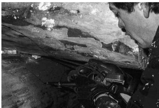
Obr. 4.7 Práce se srubařským kružítkem [14]
