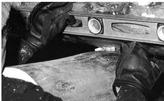
Obr. 4.8 Práce se srubařským kružítkem [14]
