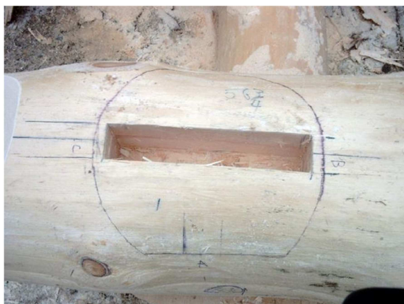
Obr. 3.16 Dlab do kulatiny [16]
