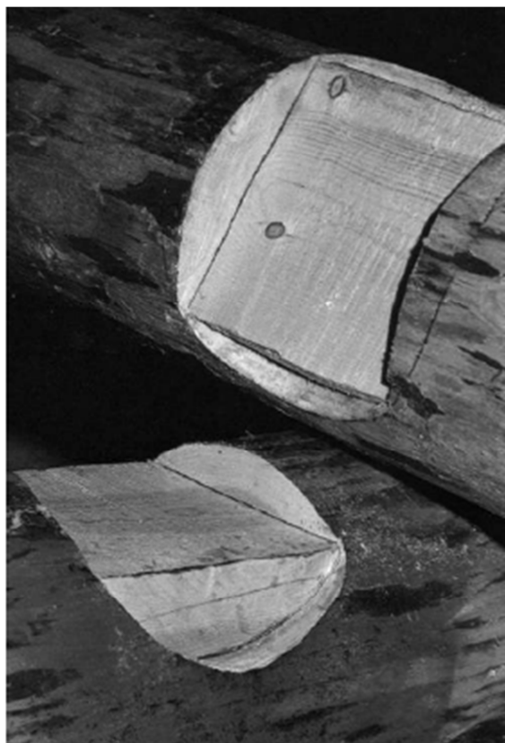
Obr. 4.11 Čtvercový příčný spoj [14]
