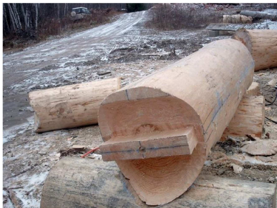
Obr. 3.15 Čepování sloupů [16]
