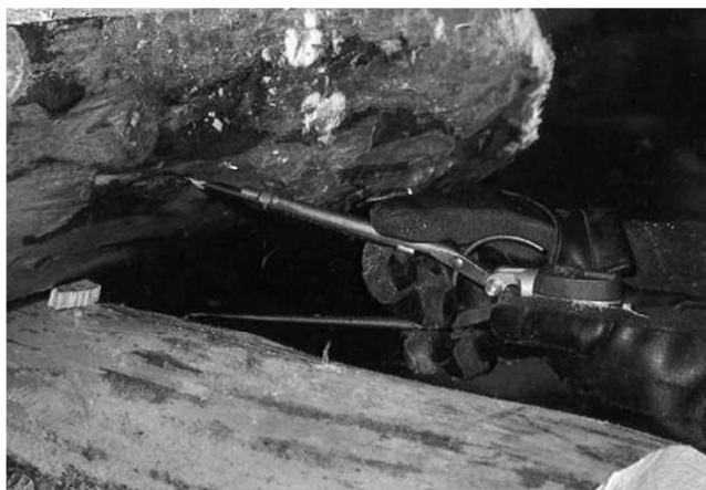
Obr. 4.6 Práce se srubařským kružítkem [14]
