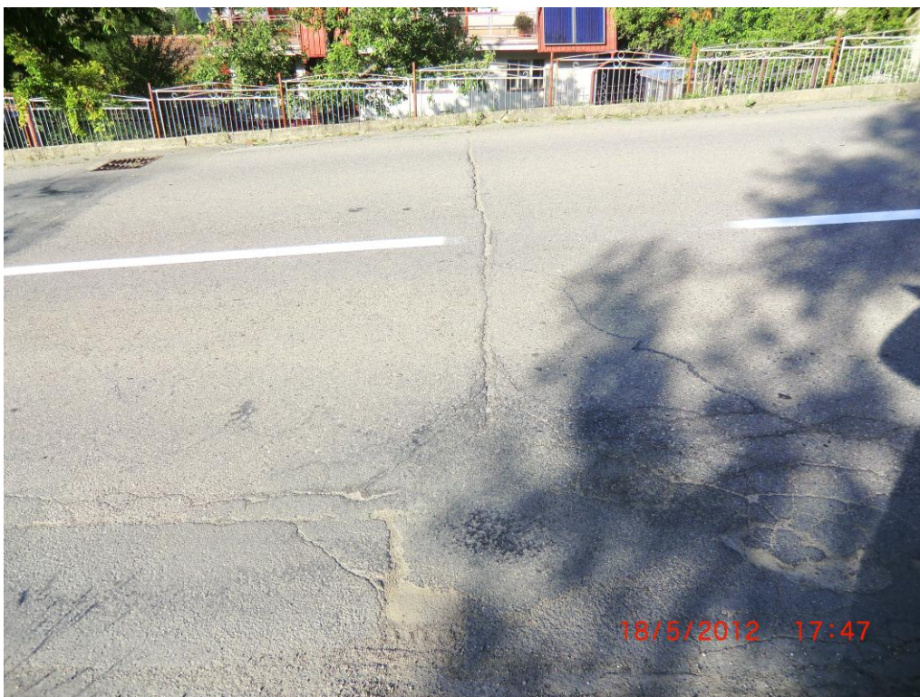
Foto č.13 – výtluk, porucha pracovní spáry, mozaiková trhlina, „pocení vozovky“ (km 0,353)
