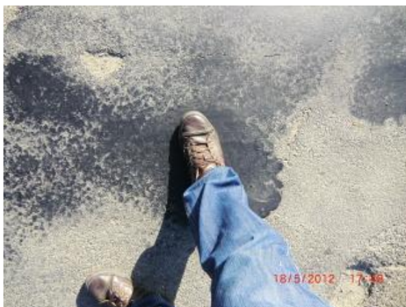
Foto č.16, 17 – vyspráva tryskovou metodou, dochází k „pocení vozovky“ – ztráta protismykových vlastností
