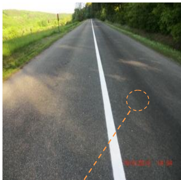
Foto č.33 – ztráta kameniva z nátěru
