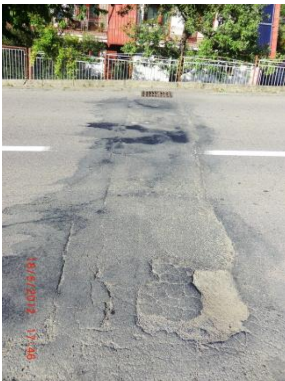
Foto č.13 – výtluk, porucha pracovní spáry, mozaiková trhlina, „pocení vozovky“ (km 0,353)
