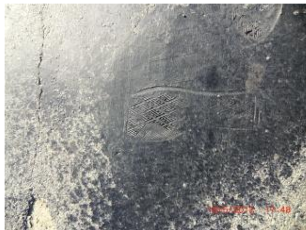
Foto č.16, 17 – vyspráva tryskovou metodou, dochází k „pocení vozovky“ – ztráta protismykových vlastností
