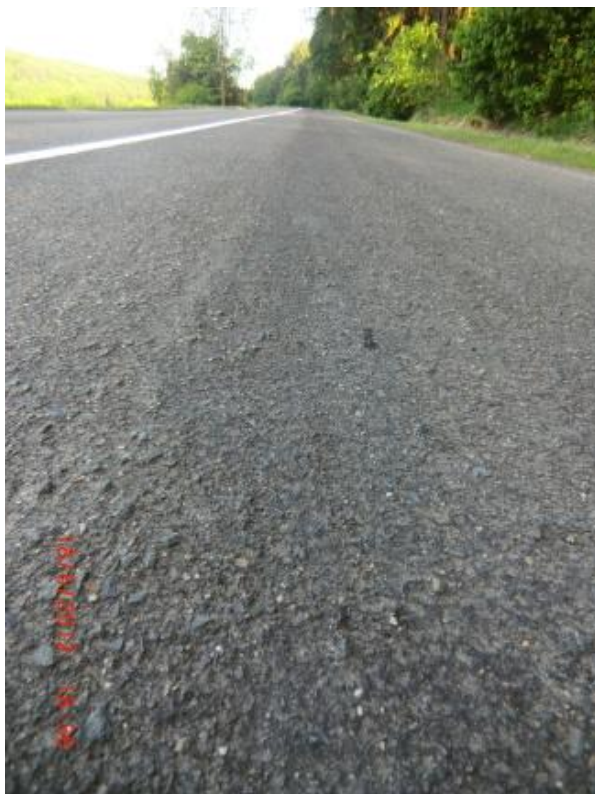
Foto č.35 – ztráta kameniva z nátěru
