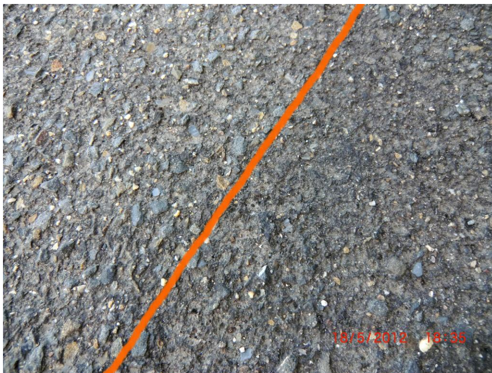
Foto č.34 – ztráta kameniva z nátěru
