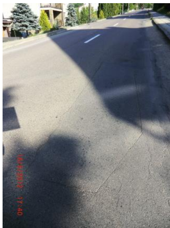
Foto č.10 – vyspráva (km 0,265)
