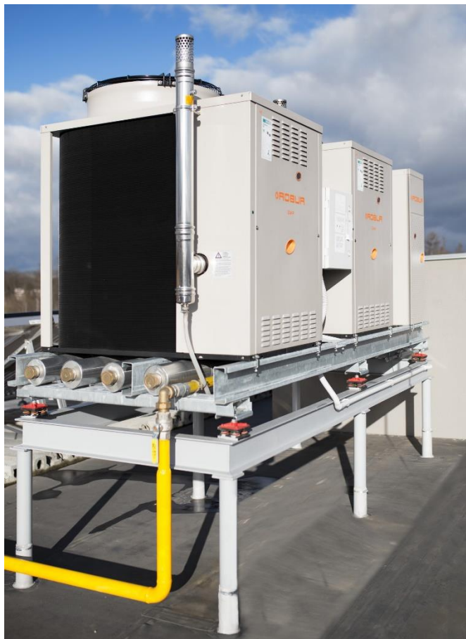
Obrázek 20 Instalace plynového tepelného čerpadla [38]
