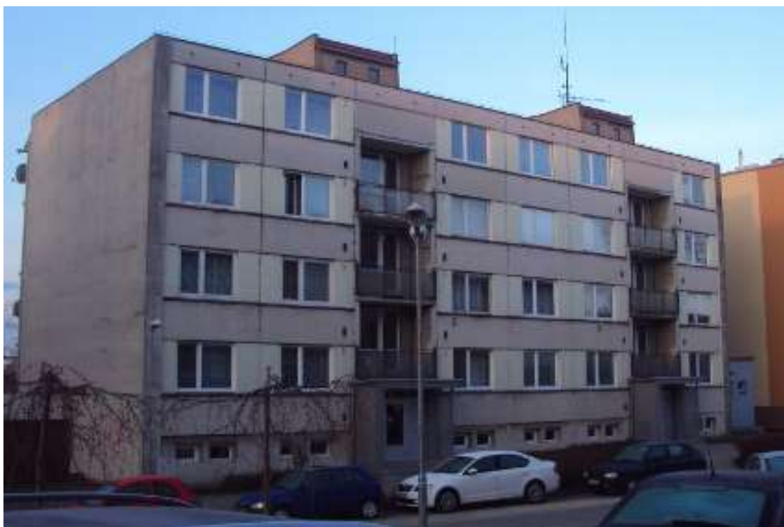
Obr. 7.1 Severní strana budovy
