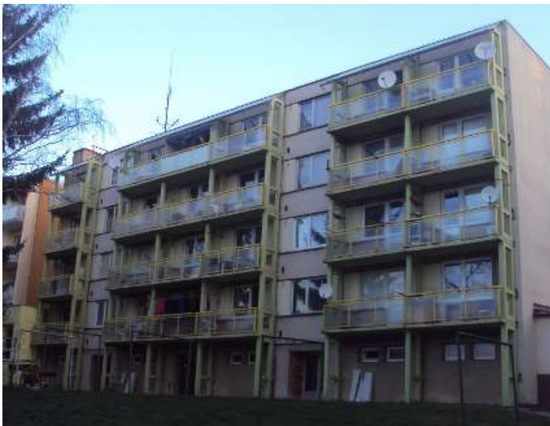
Obr. 7.2 Jižní strana budovy
