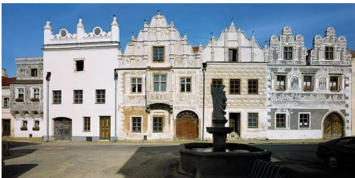
Obr. 1.3 Typické gotické domy v obci Slavonice 3
