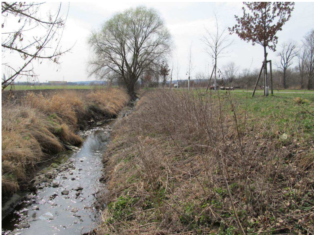
Obr. 28: Opevnění koryta a doprovodná vegetace
