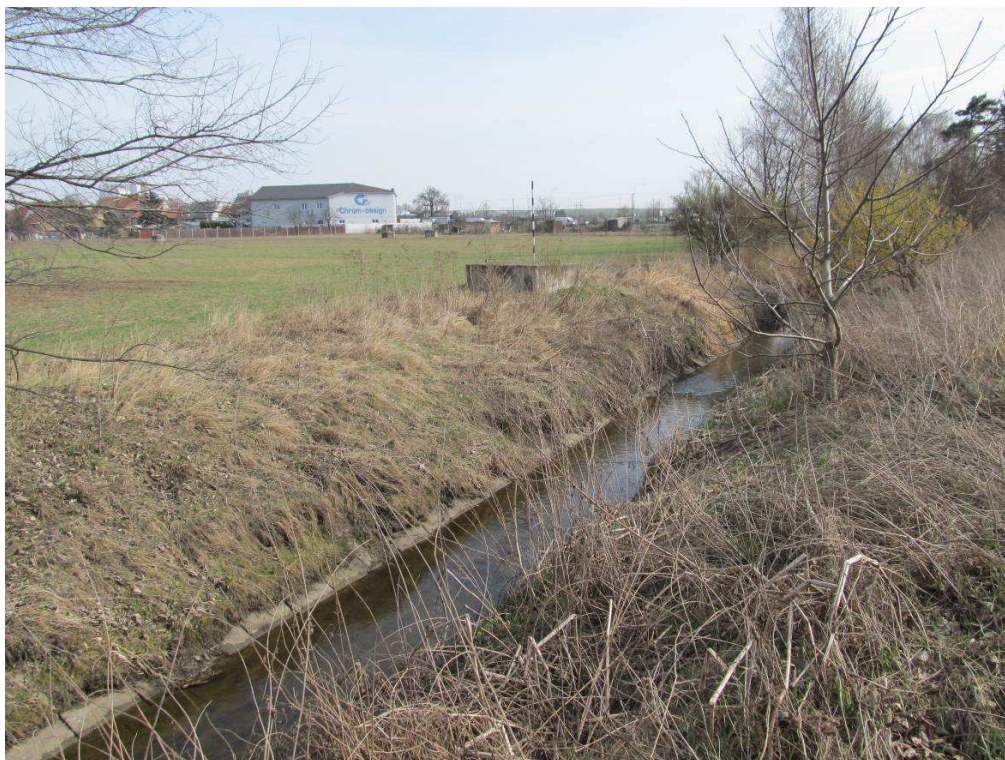
Obr. 22: Opevnění břehu betonovými dlaždicemi
