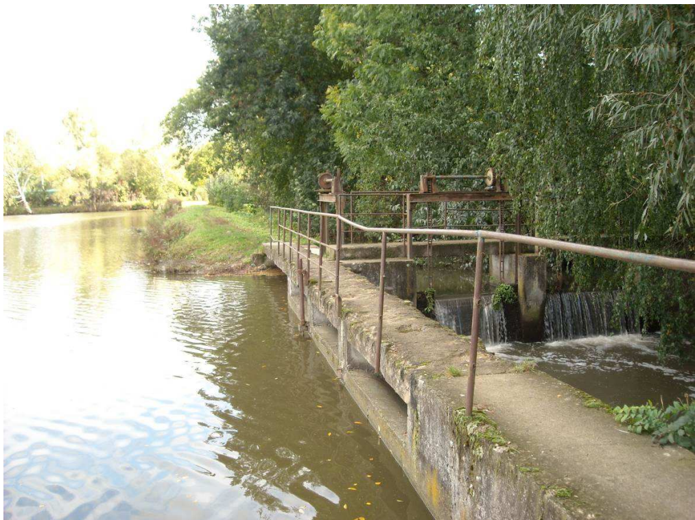
Obr. 13: Stavidlový objekt km 1,547
