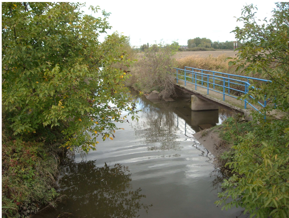
Obr. 17 Soutok s kanálem K2 km 2,947
