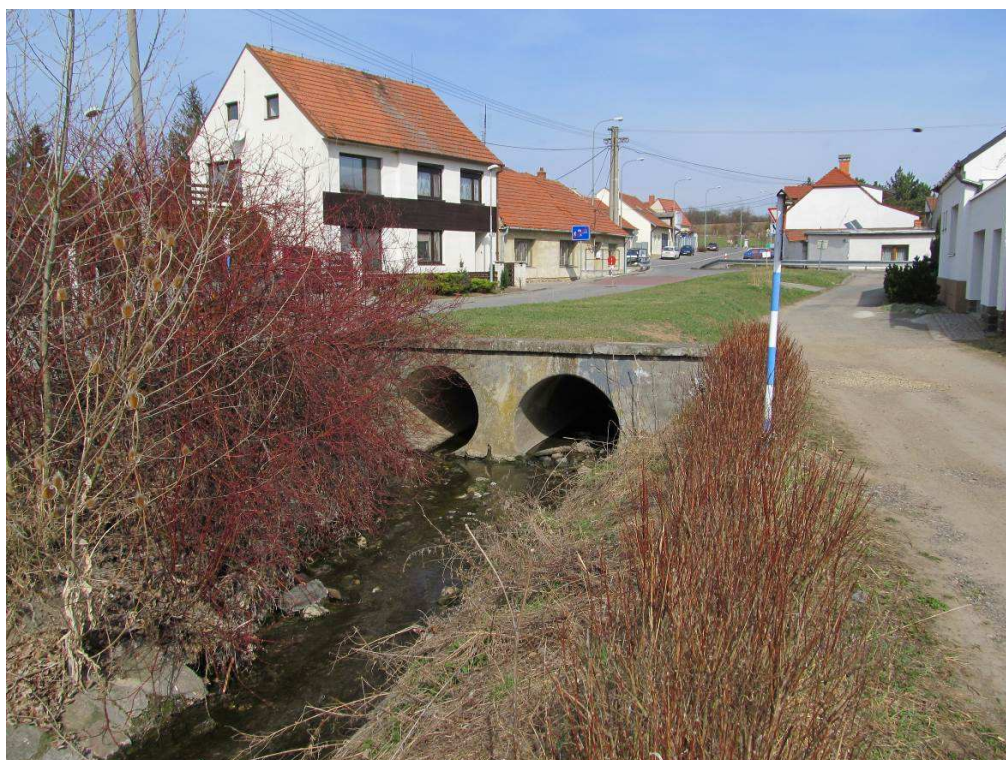
Obr. 29: Vyústění ze zatrubnění km 6,882
