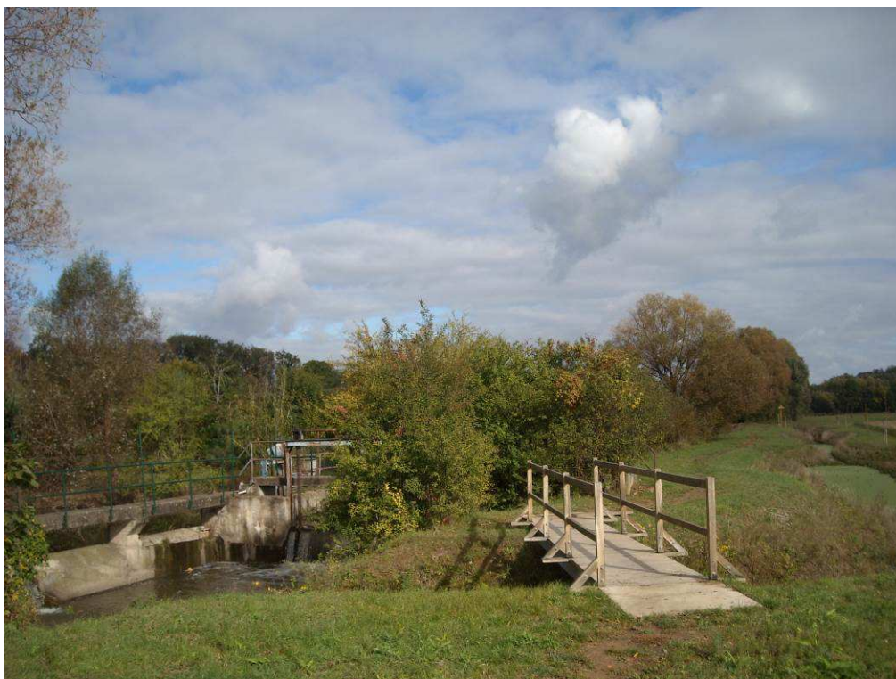
Obr. 8: Levostranný přítok a stavidlo km 0,304
