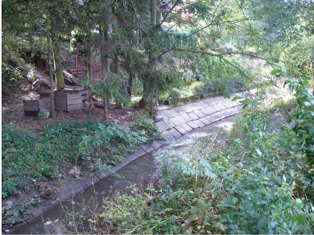
Obr. 12: Opevnění dna a břehů
