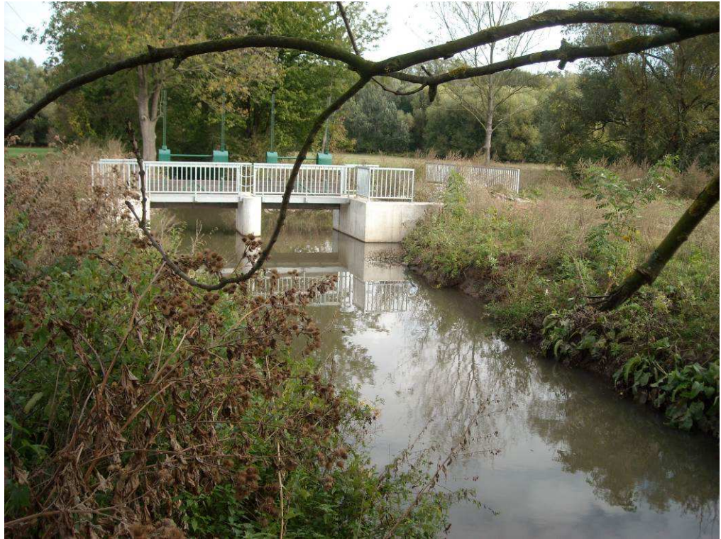
Obr. 9: Stavidlový objekt km 0,802
