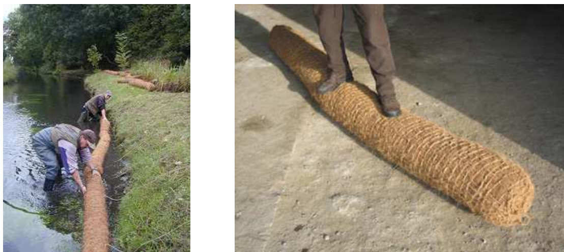
Obr. 3.11: Ukázka použití a pevnosti kokosového válce od firmy BEŇO biotech [17]
