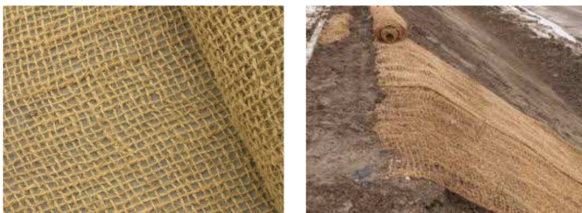
Obr. 3.5: Detail kokosové sítě vlevo a rozvinutá kokosová síť vpravo [18]
