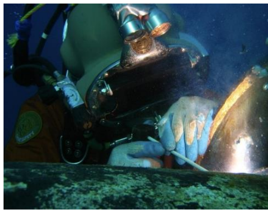
Obr. 22 Mokré zváranie so špeciálnou elektródou [47].
