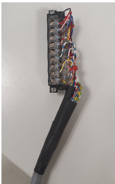
Obr. 4.2: Upravené kabelové spojení se svorkovnicí
