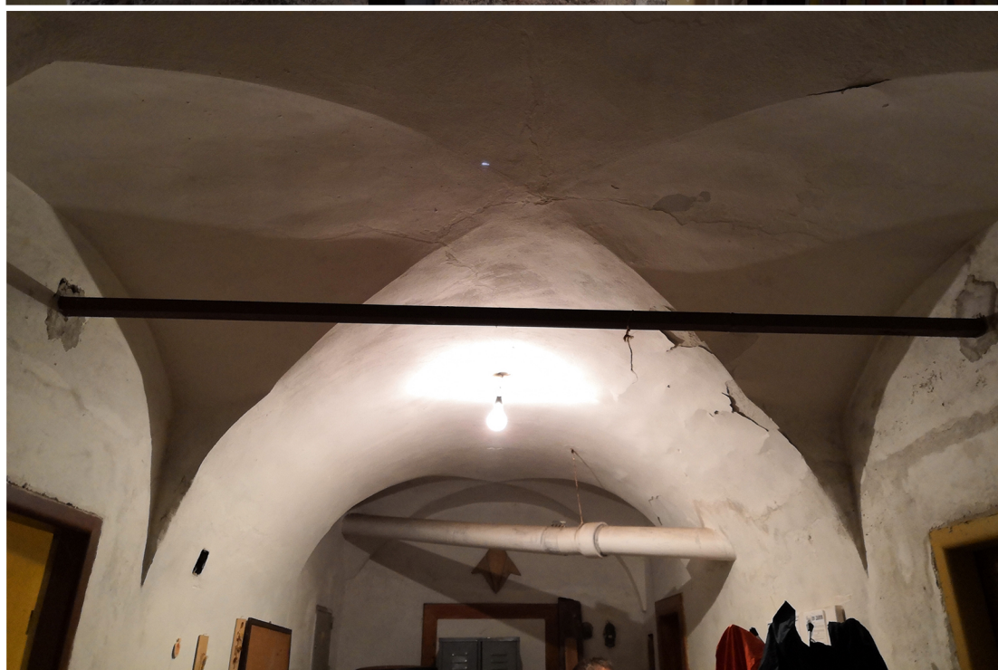
obr. č. 5 a 6: neoborné zásahy a nevhodné vytváranie prestupov v konštrukciách klenieb
