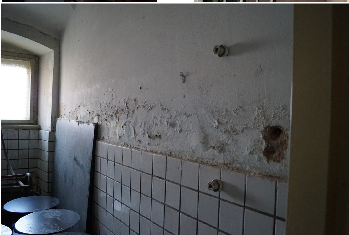
obr. č. 4: prejav vlhkosti na stenách interiéru 1.np
