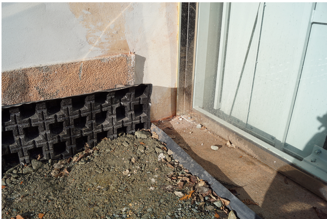
obr. č. 14: pokusy o sanáciu vlhkého mur- iava nopovou fóliou
