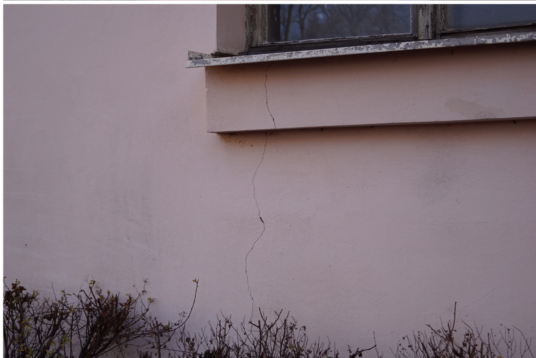
obr. č. 13: trhlina na fasáde pravdepodobne spôsobená rozdielnou objemovou rozťažnosťou murovacích prvkov
