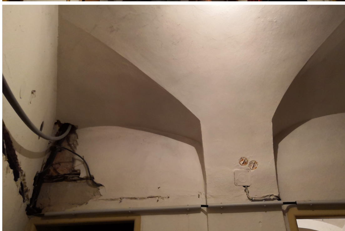
obr. č. 7: nepôvodné členenie dispozícií nevhodne zasahuje do klenieb
