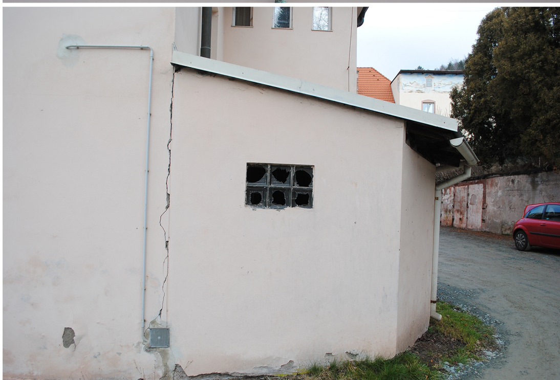
obr. č. 16: nepôvodná prístavba, zrejme zle založená
