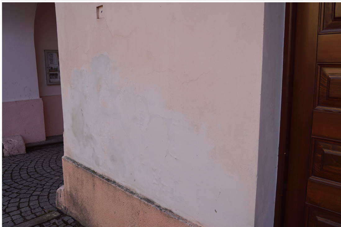
obr. č. 11 a 12: prejavy vlhkosti muriva na obvodových stenách - vlhkostné mapy
