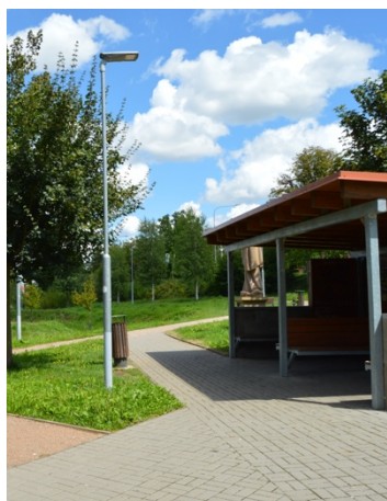
Obrázek 50 Pumptrack altán [Zdroj: autor]
