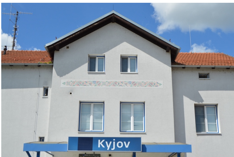
Obrázek 38 Vlaková stanice – detail fasáda [Zdroj: autor]
