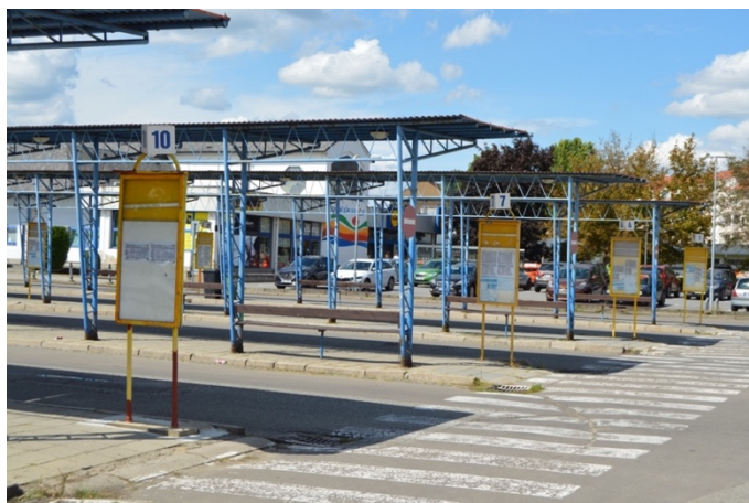
Obrázek 33 Autobusové nádraží - zastávky [Zdroj: autor]
