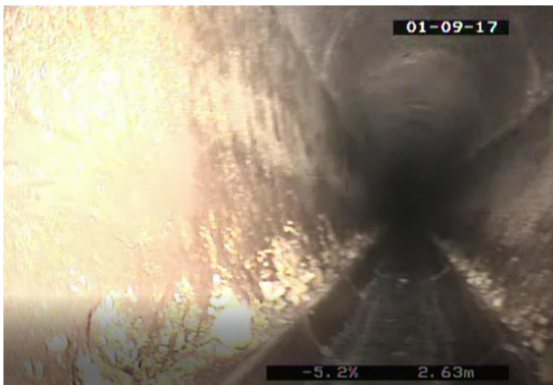
Obrázek 3.23 Fotografie z kamerového průzkumu [9]
