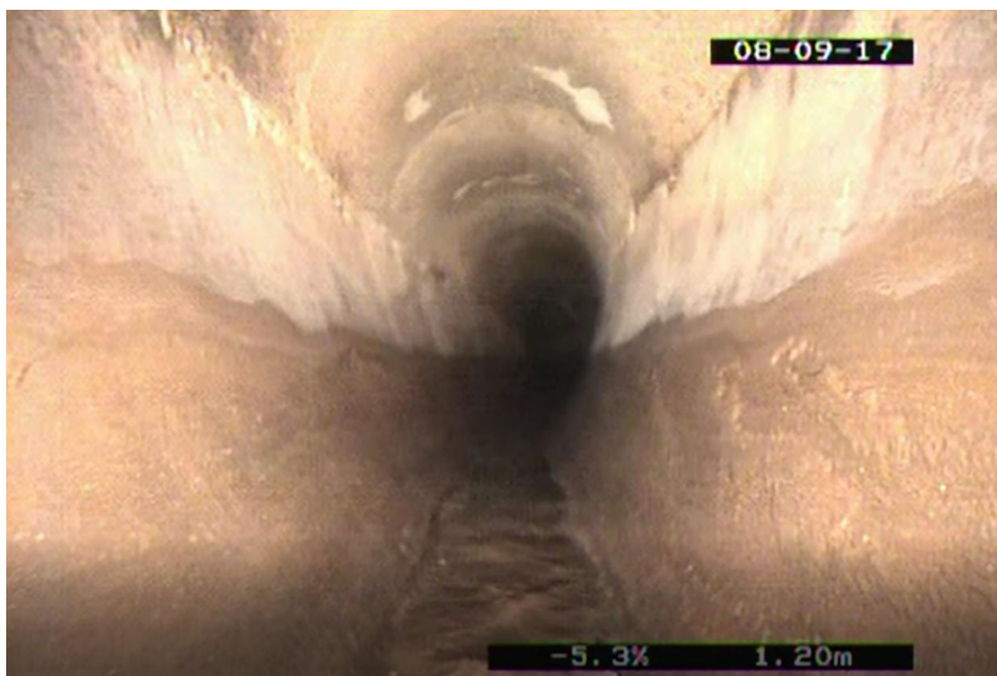
Obrázek 3.37 Fotografie z kamerového průzkumu [9]
