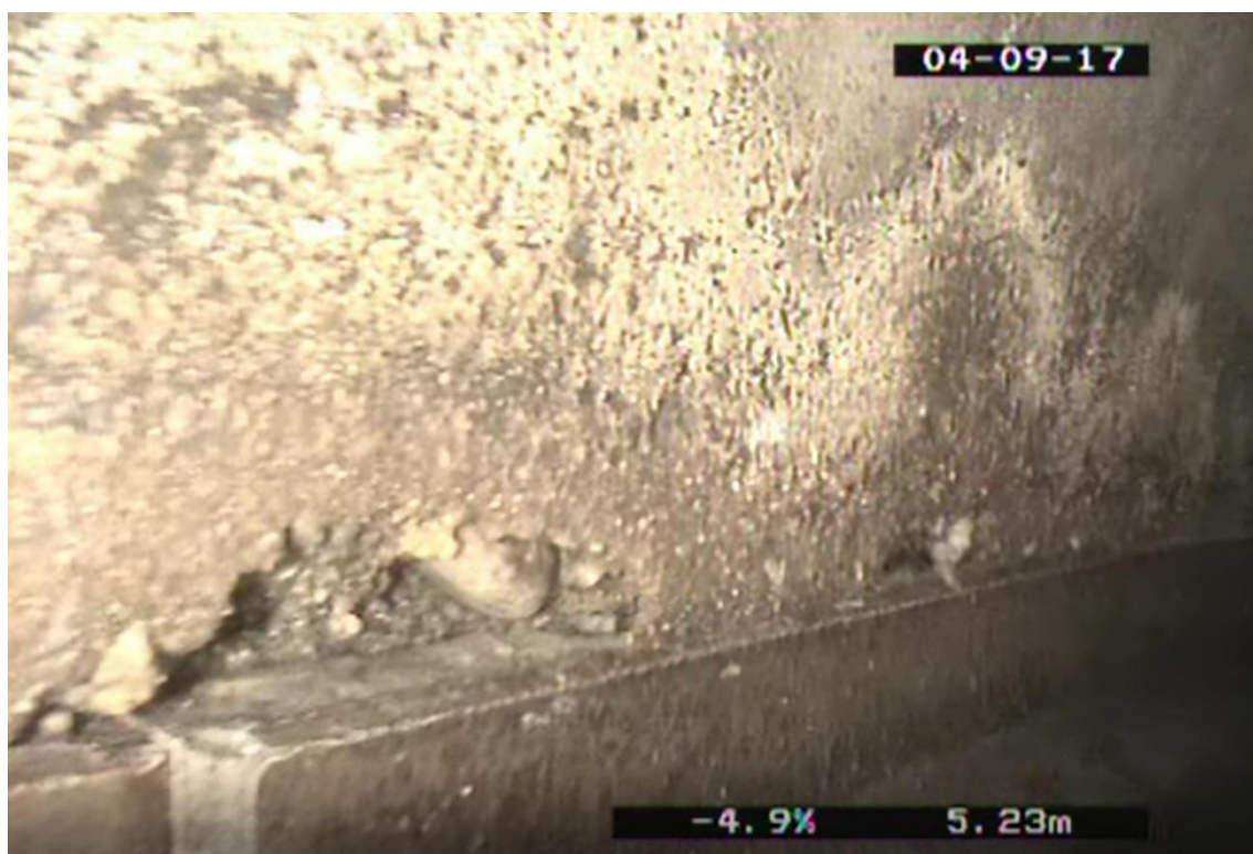
Obrázek 3.10 Fotografie z kamerového průzkumu [9]
