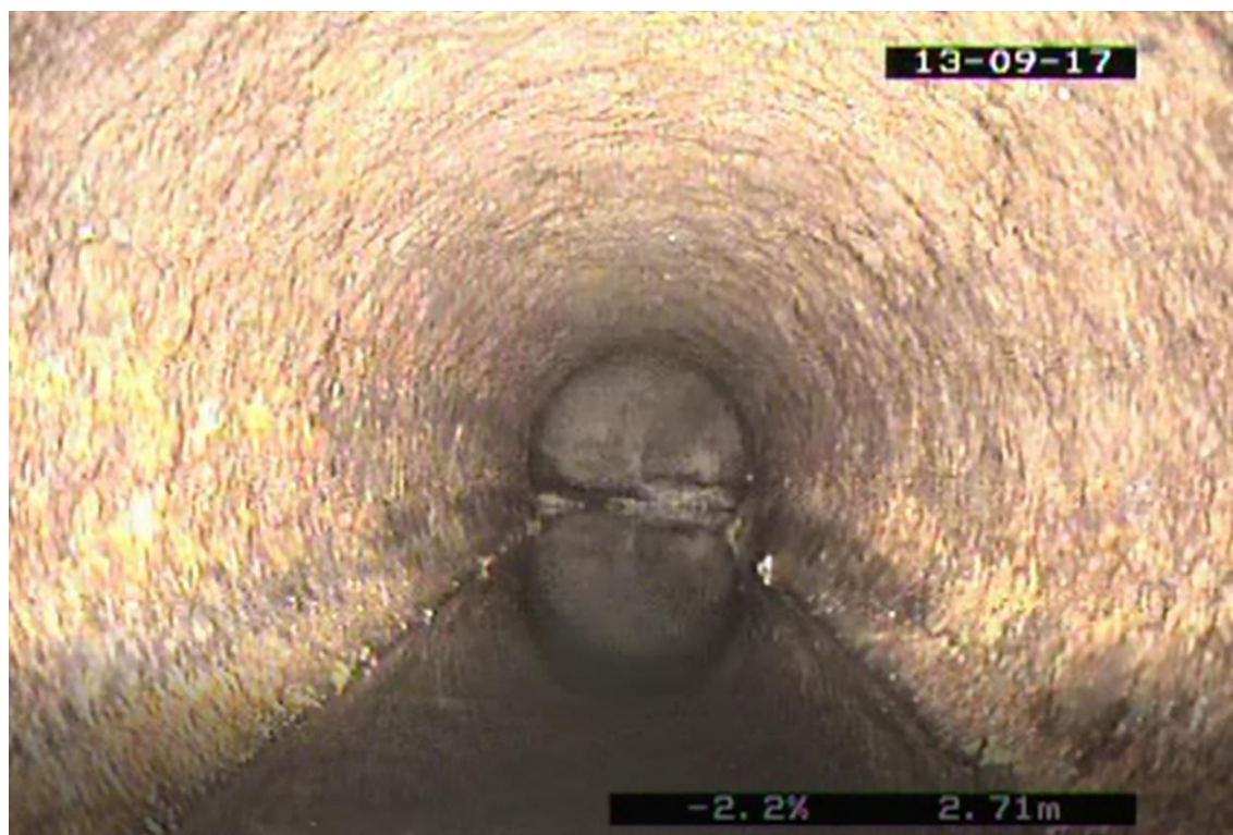
Obrázek 3.35 Fotografie z kamerového průzkumu [9]
