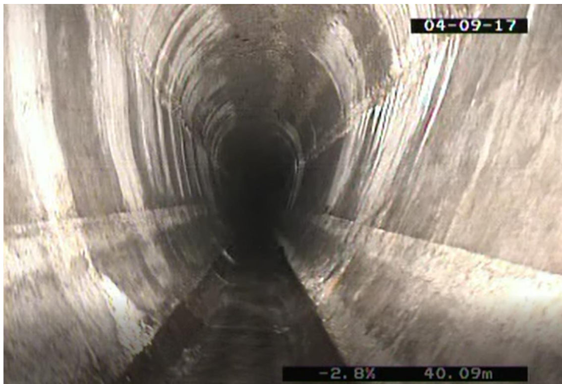
Obrázek 3.11 Fotografie z kamerového průzkumu [9]
