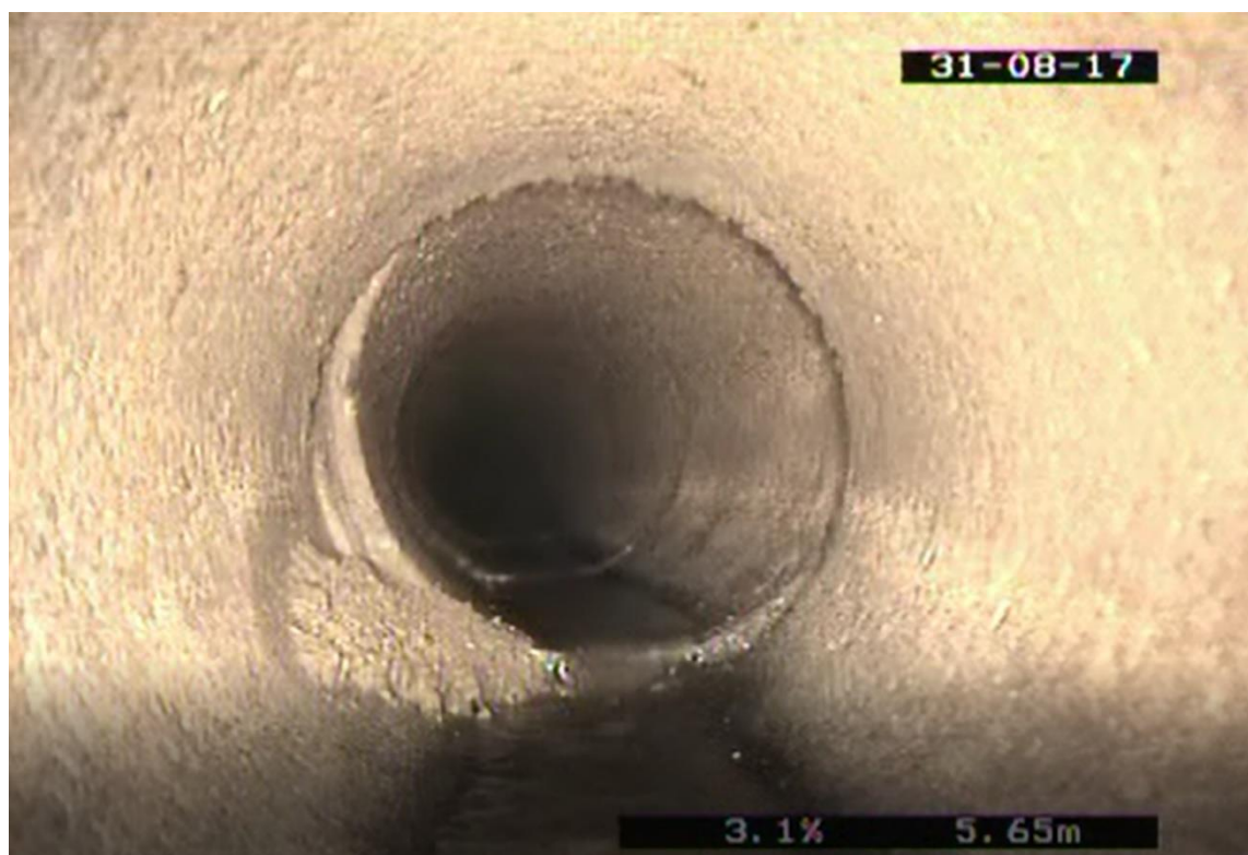
Obrázek 3.31 Fotografie z kamerového průzkumu [9]
