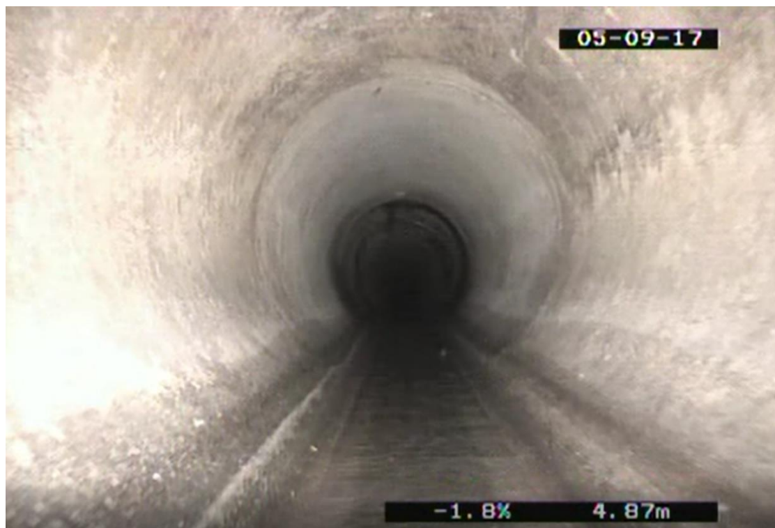
Obrázek 3.14 Fotografie z kamerového průzkumu [9]
