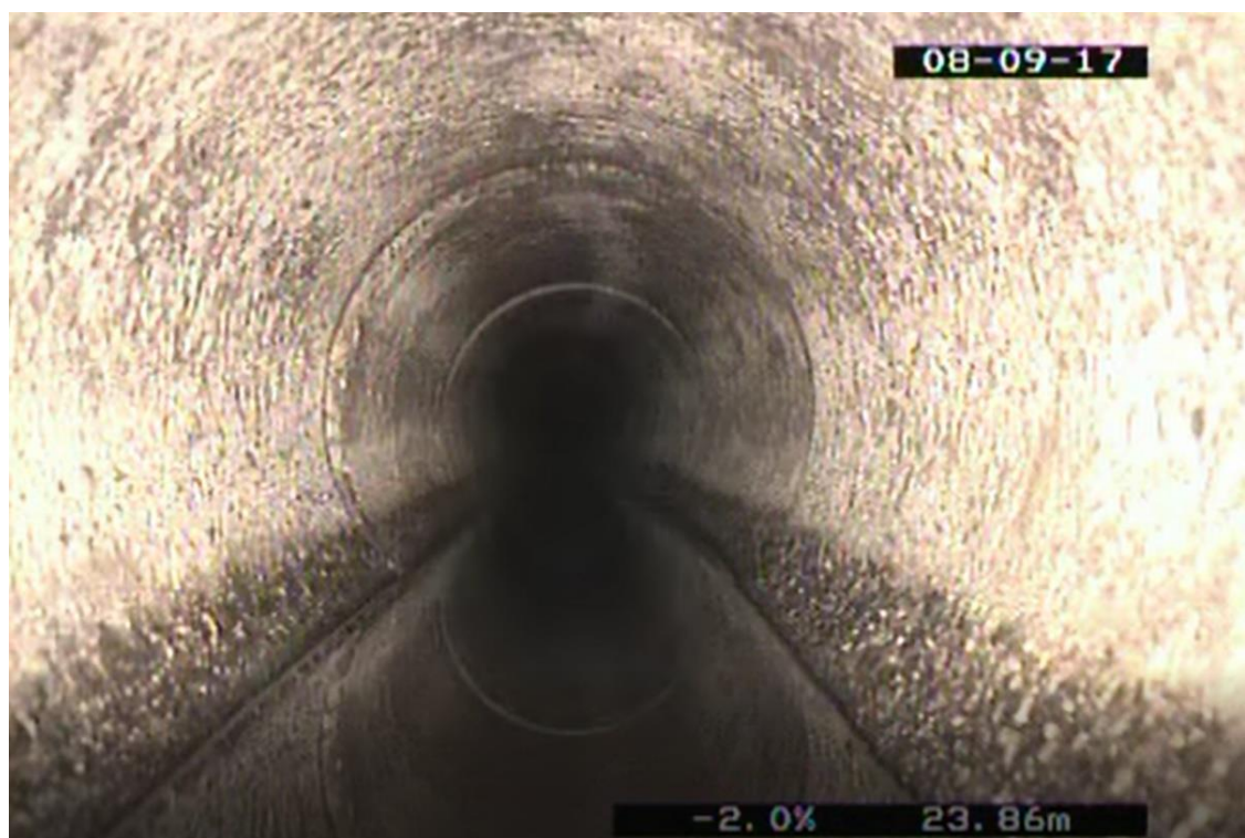
Obrázek 3.30 Fotografie z kamerového průzkumu [9]
