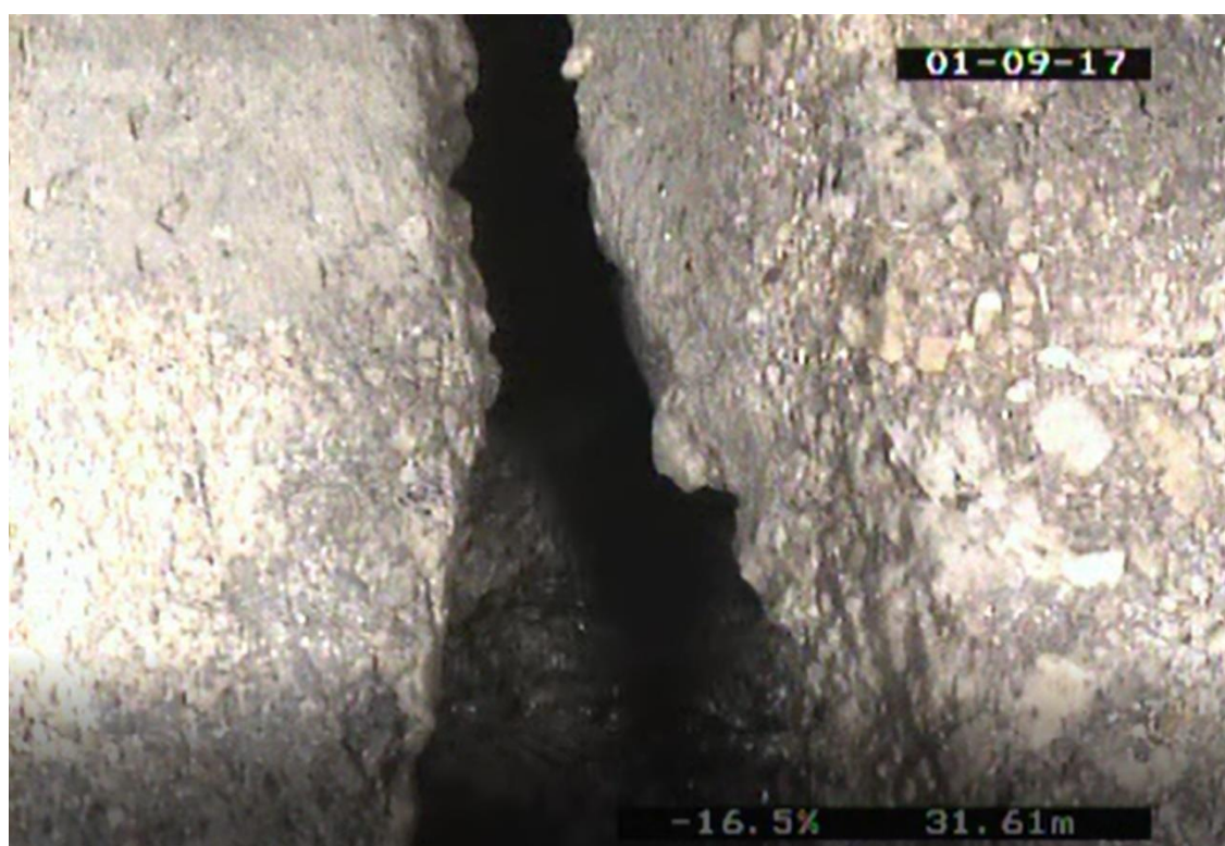
Obrázek 3.26 Fotografie z kamerového průzkumu [9]
