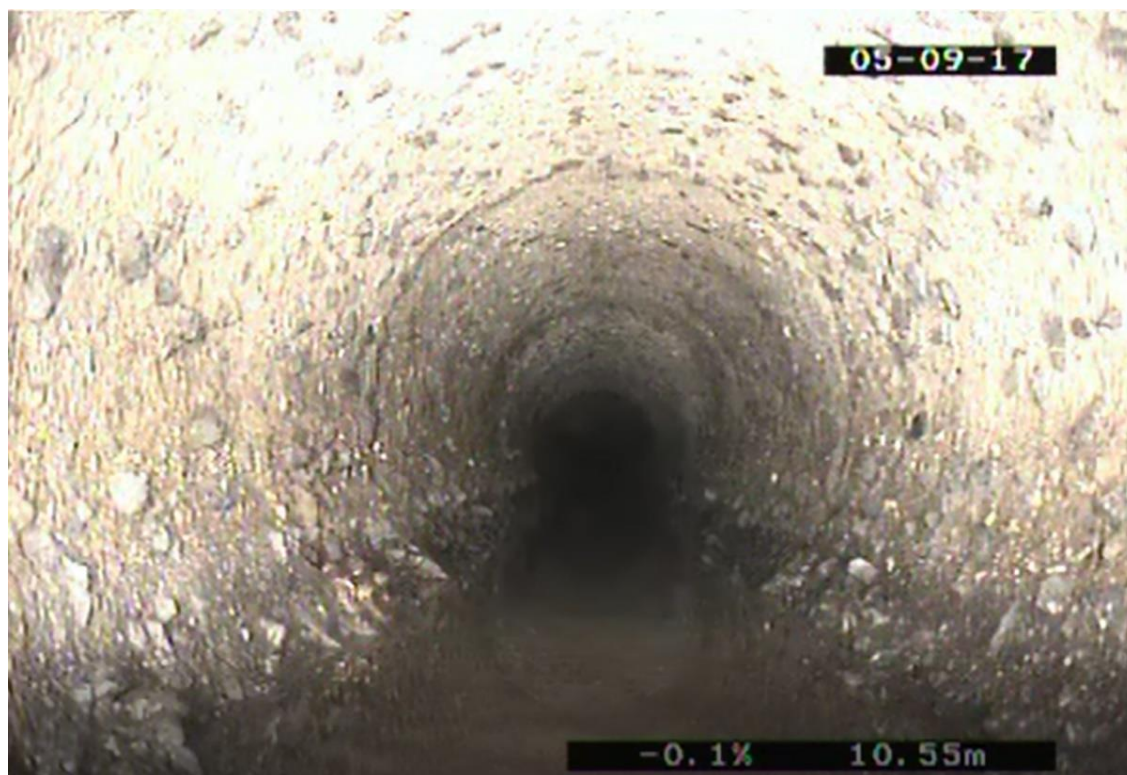
Obrázek 3.19 Fotografie z kamerového průzkumu [9]
