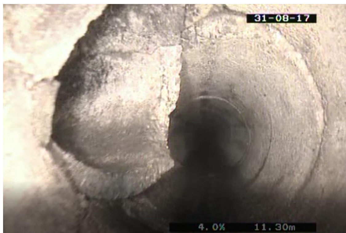
Obrázek 3.5 Fotografie z kamerového průzkumu [9]
