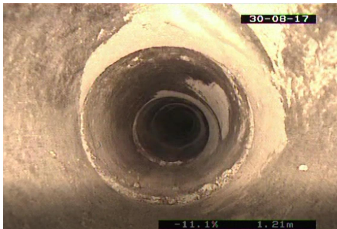
Obrázek 3.1 Fotografie z kamerového průzkumu [9]
