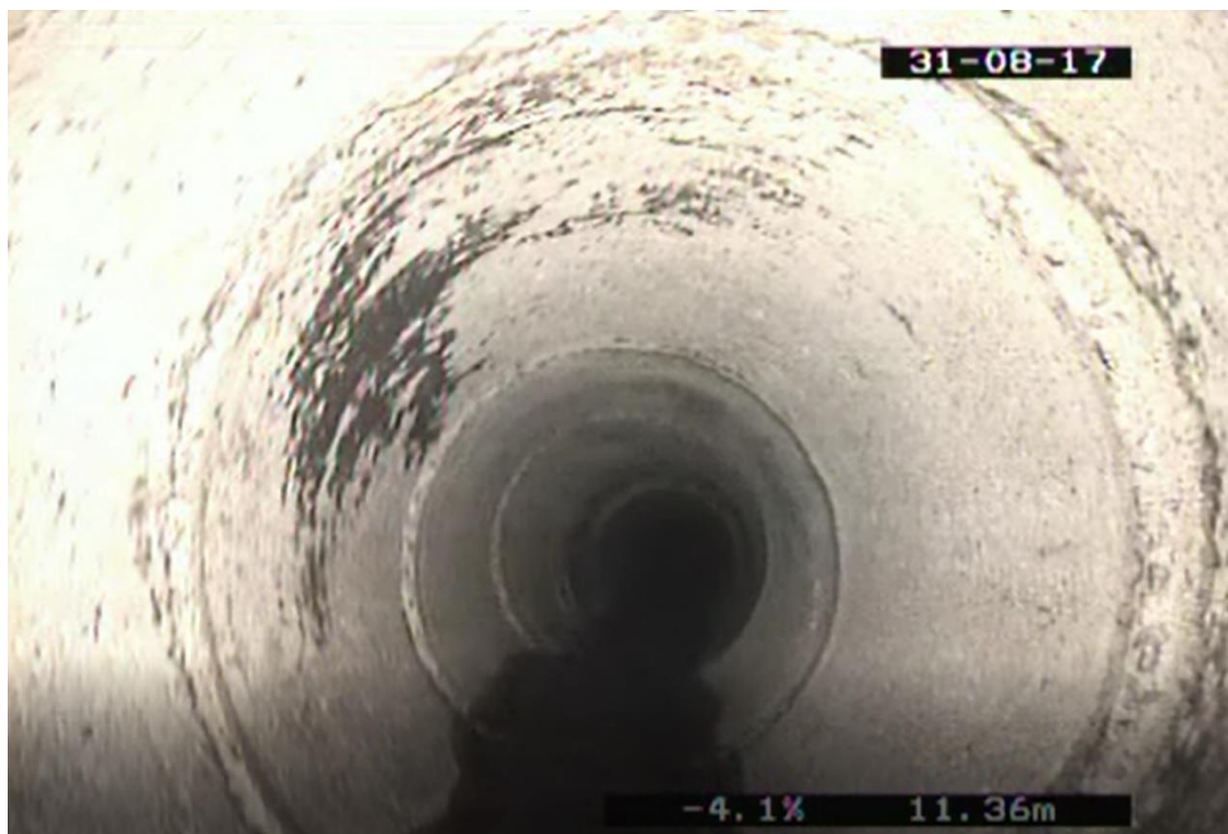
Obrázek 3.9 Fotografie z kamerového průzkumu [9]
