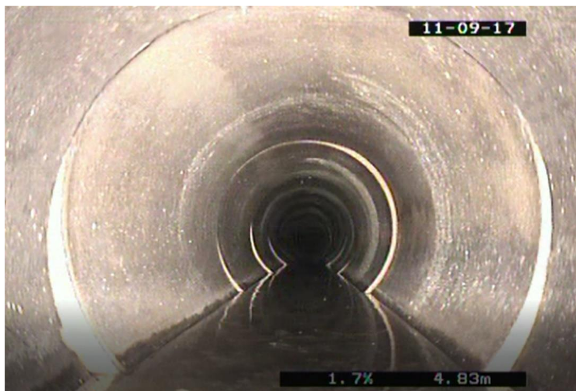
Obrázek 3.18 Fotografie z kamerového průzkumu [9]
