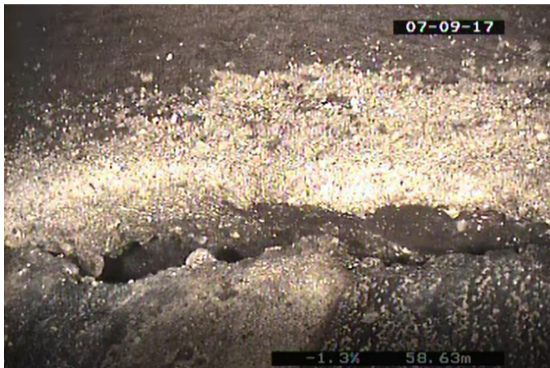
Obrázek 3.38 Fotografie z kamerového průzkumu [9]
