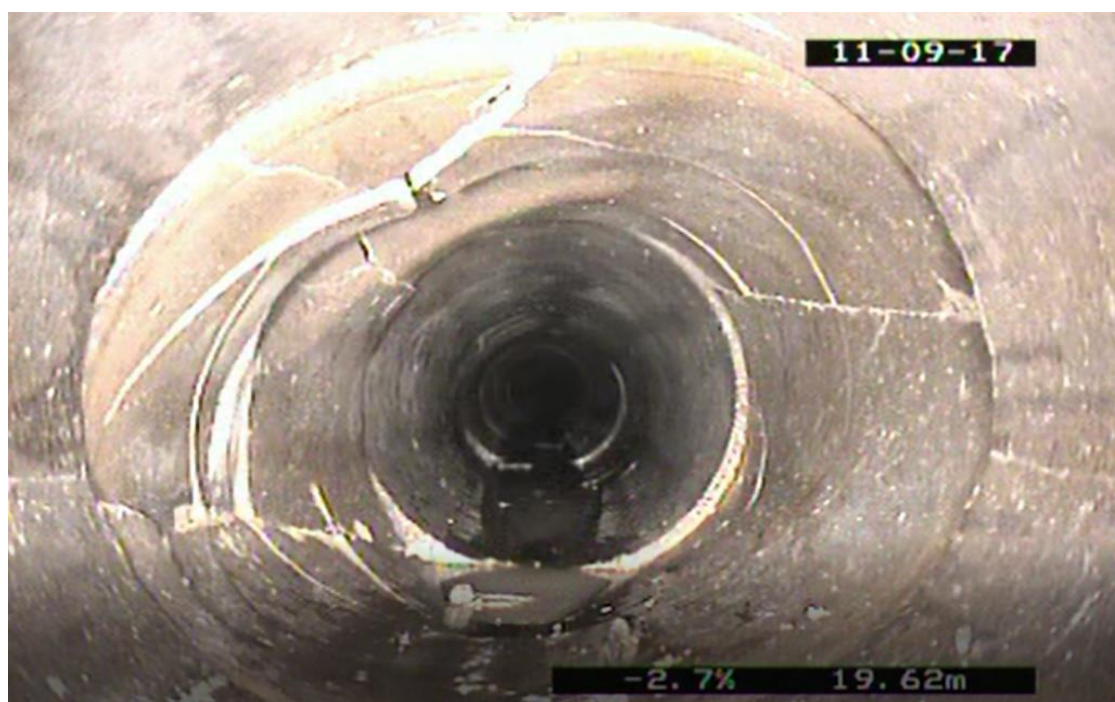
Obrázek 3.16 Fotografie z kamerového průzkumu [9]
