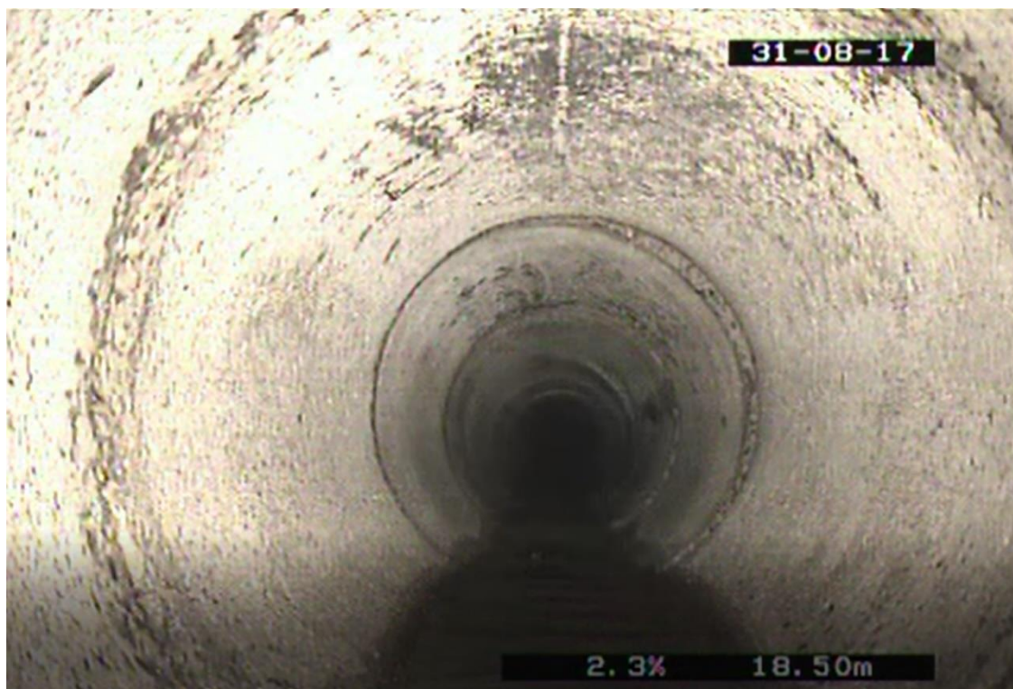
Obrázek 3.8 Fotografie z kamerového průzkumu [9]
