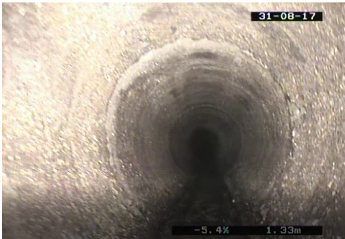
Obrázek 3.4 Fotografie z kamerového průzkumu [9]
