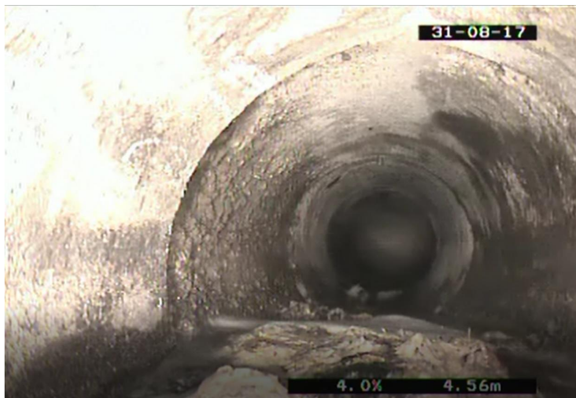
Obrázek 3.3 Fotografie z kamerového průzkumu [9]
