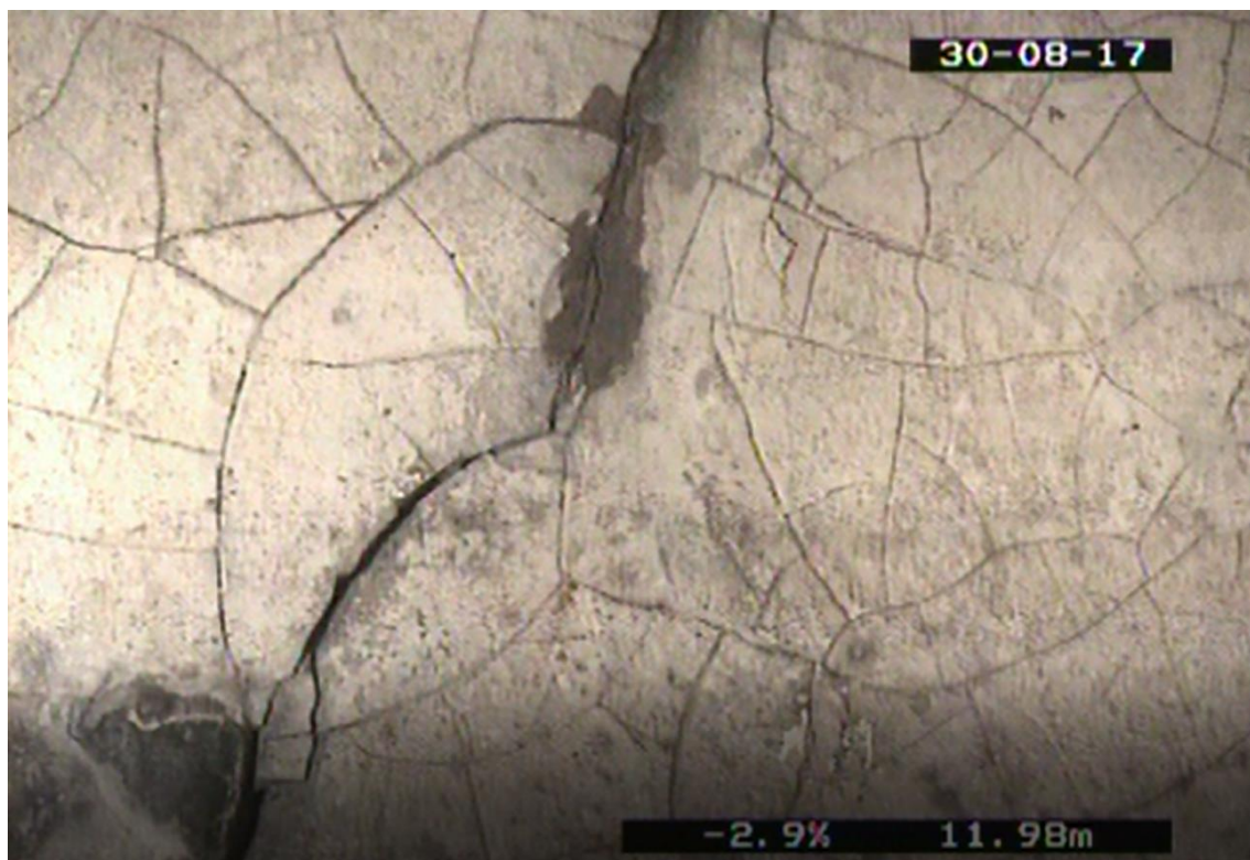
Obrázek 3.7 Fotografie z kamerového průzkumu [9]
