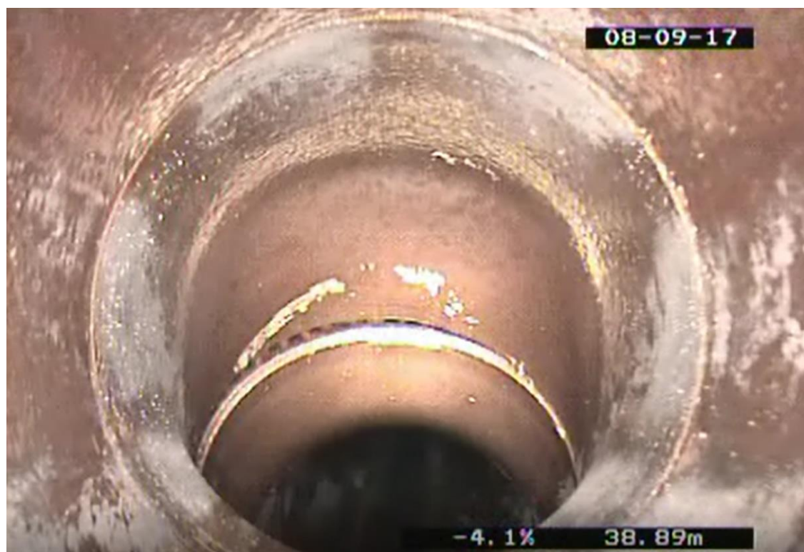
Obrázek 3.28 Fotografie z kamerového průzkumu [9]
