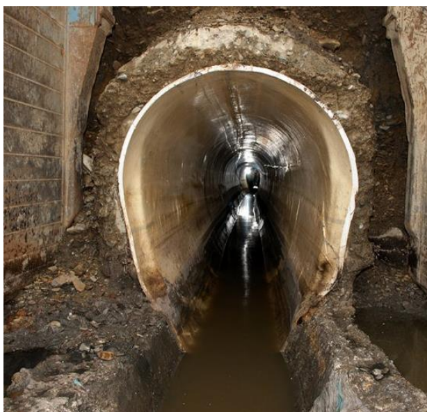
Obrázek 5.2 Ukázka sanovaného vejčitého profilu metodou KAWO [14]
