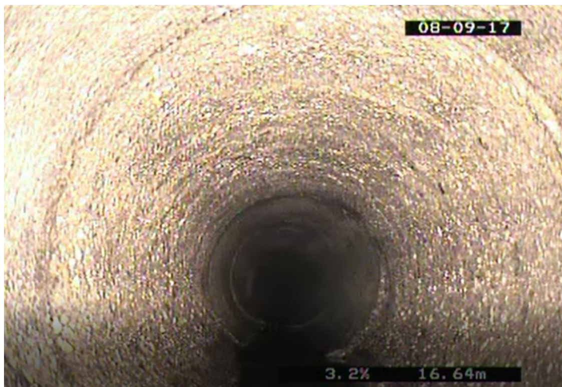
Obrázek 3.29 Fotografie z kamerového průzkumu [9]
