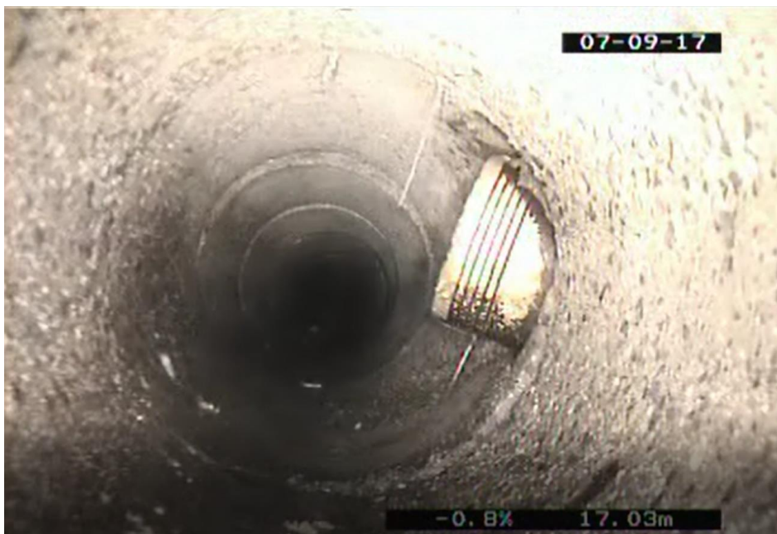
Obrázek 3.40 Fotografie z kamerového průzkumu [9]
