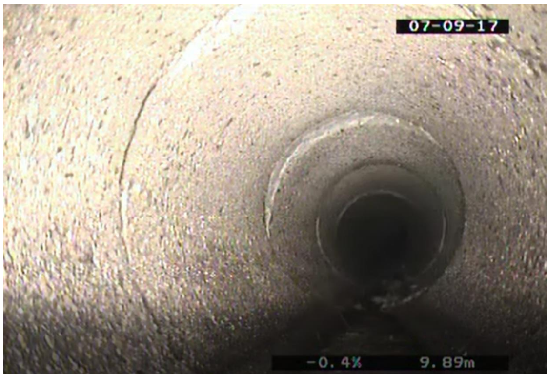
Obrázek 3.39 Fotografie z kamerového průzkumu [9]
