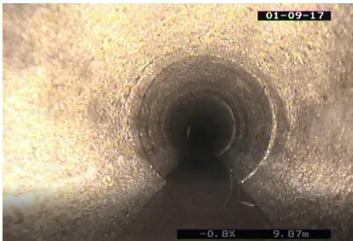
Obrázek 3.25 Fotografie z kamerového průzkumu [9]
