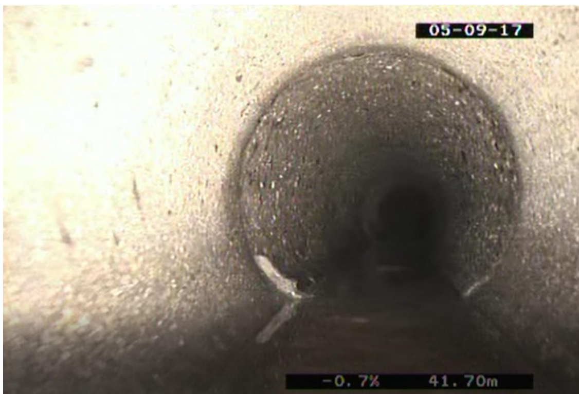
Obrázek 3.21 Fotografie z kamerového průzkumu [9]
