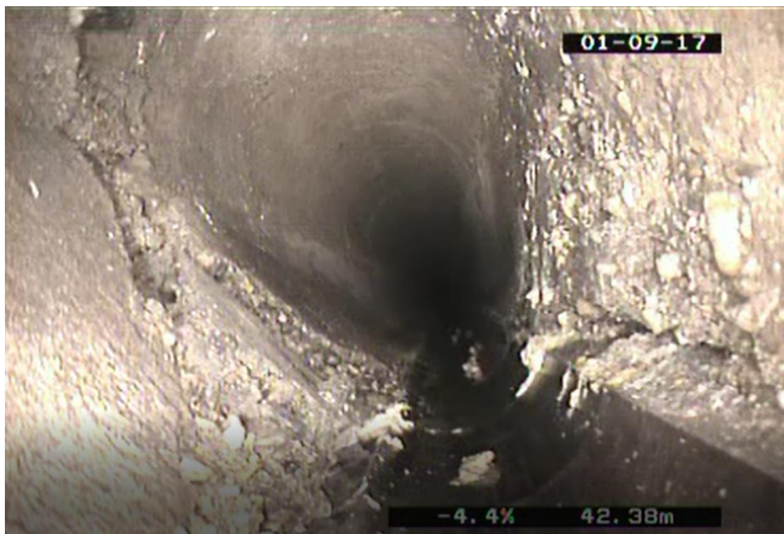
Obrázek 3.24 Fotografie z kamerového průzkumu [9]
