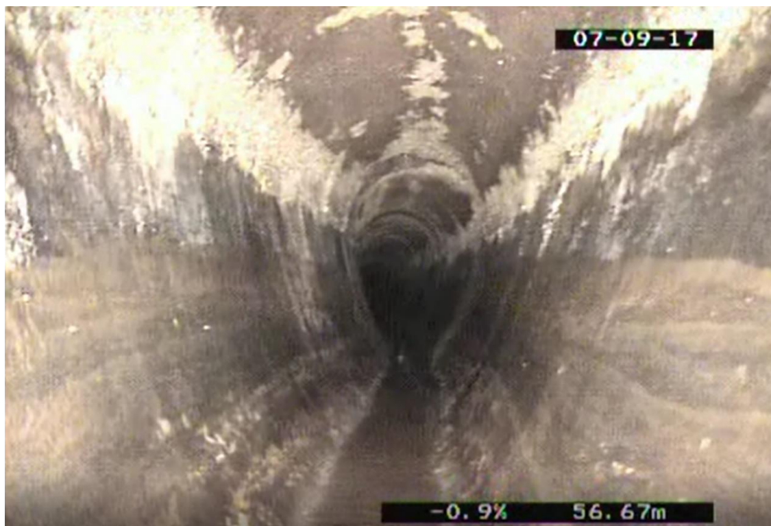
Obrázek 3.36 Fotografie z kamerového průzkumu [9]
