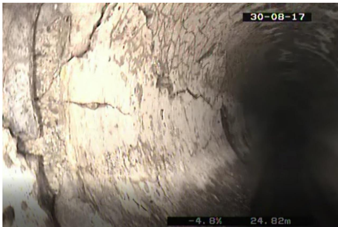
Obrázek 3.6 Fotografie z kamerového průzkumu [9]
