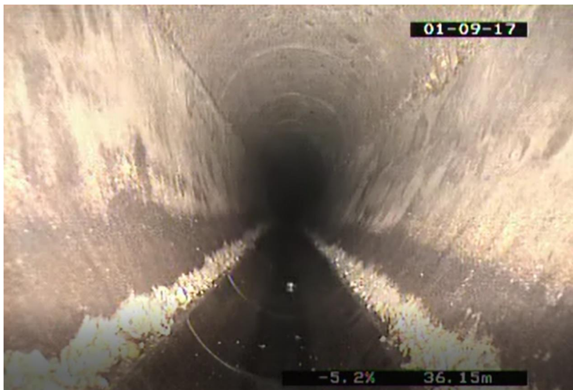
Obrázek 3.22 Fotografie z kamerového průzkumu [9]
