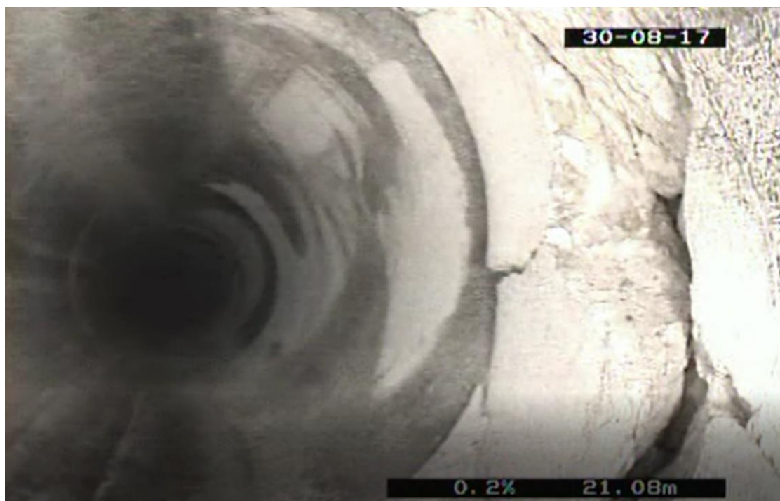
Obrázek 3.2 Fotografie z kamerového průzkumu [9]
