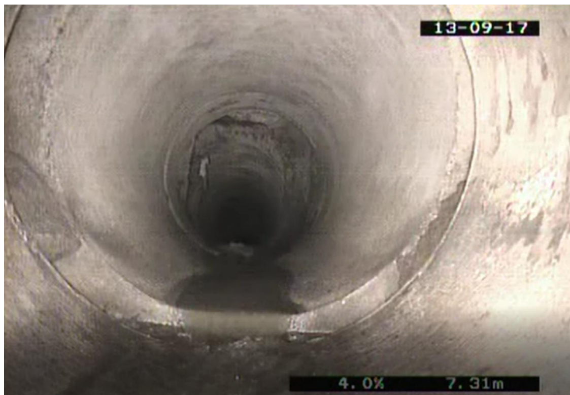
Obrázek 3.12 Fotografie z kamerového průzkumu [9]
