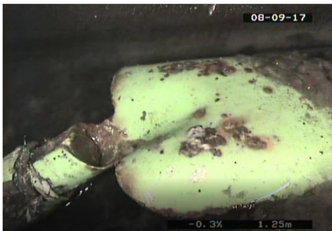
Obrázek 3.34 Fotografie z kamerového průzkumu [9]
