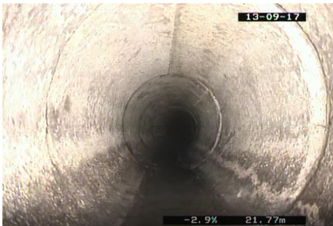
Obrázek 3.17 Fotografie z kamerového průzkumu [9]
