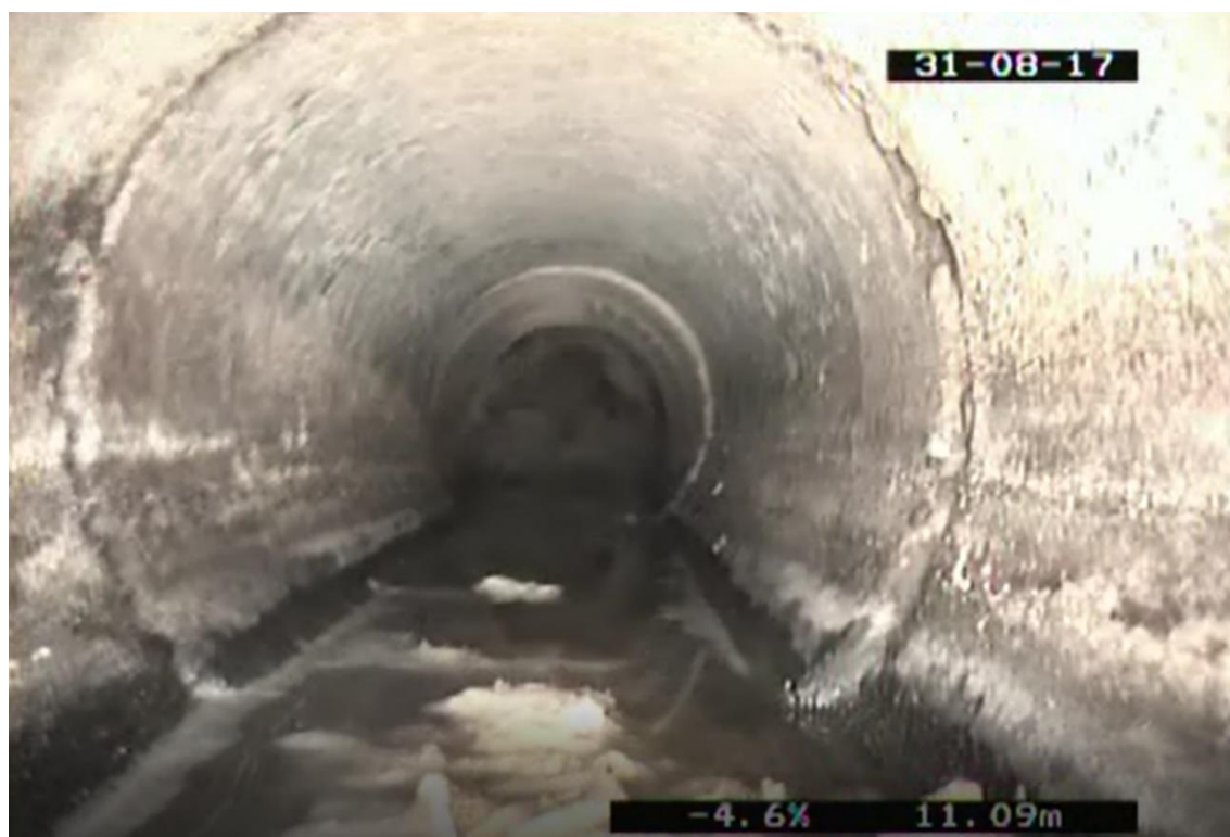
Obrázek 3.32 Fotografie z kamerového průzkumu [9]
