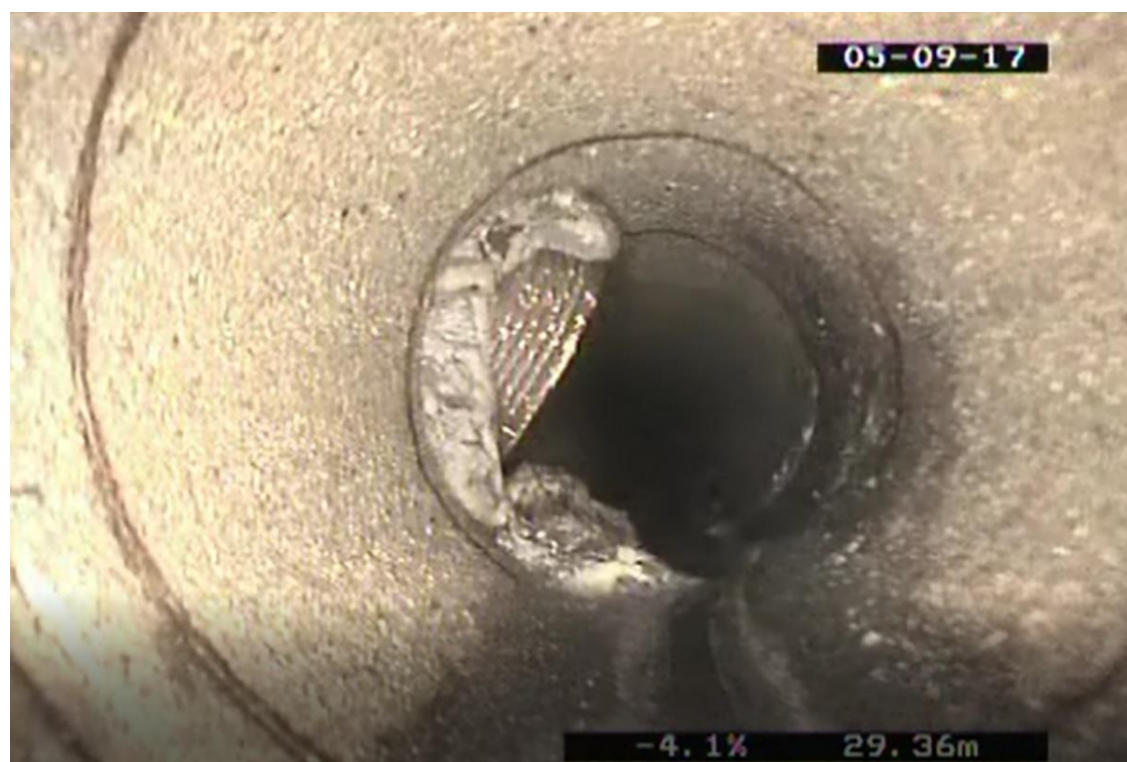
Obrázek 3.20 Fotografie z kamerového průzkumu [9]
