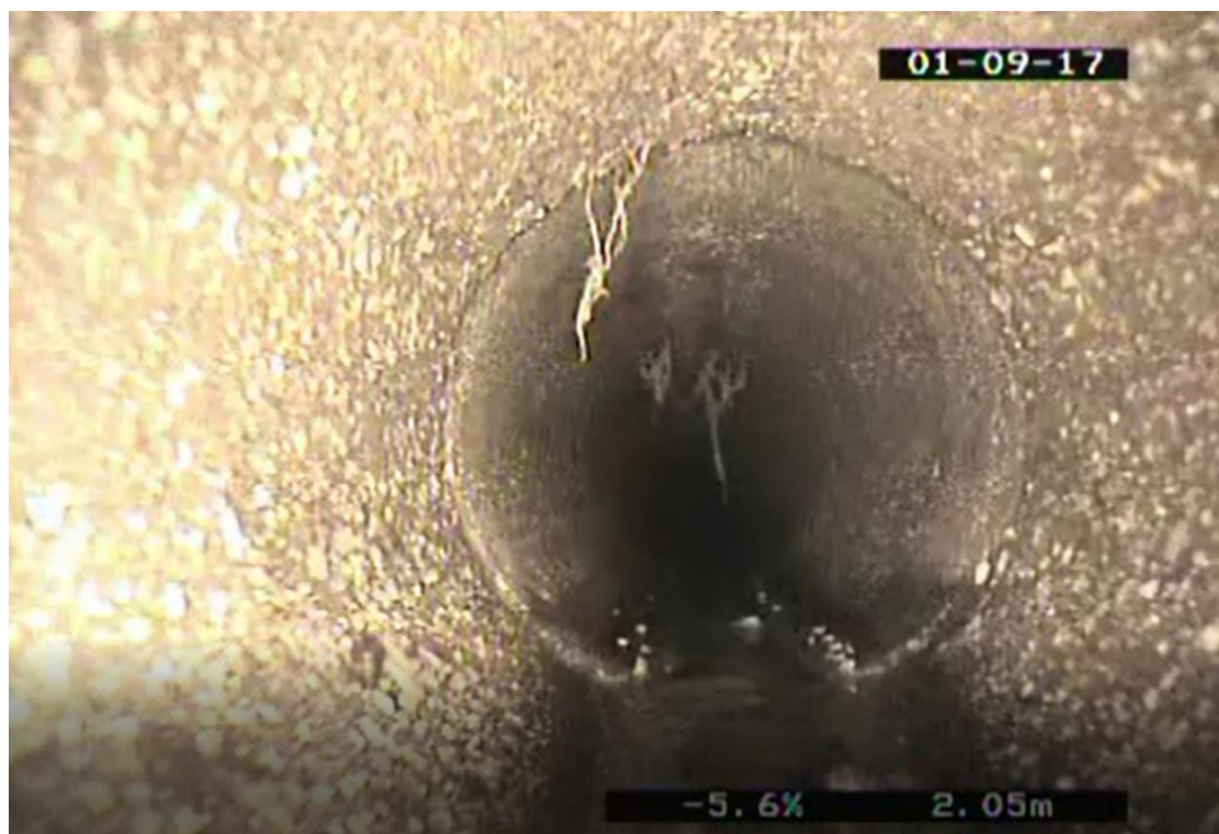
Obrázek 3.27 Fotografie z kamerového průzkumu [9]
