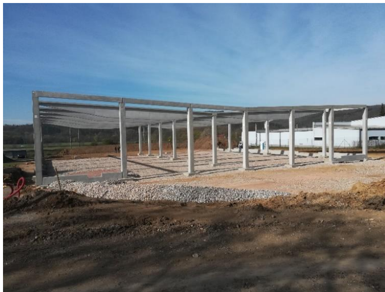
Obrázek 8 - Prefabrikovaná konstrukce haly [zdroj vlastní]
