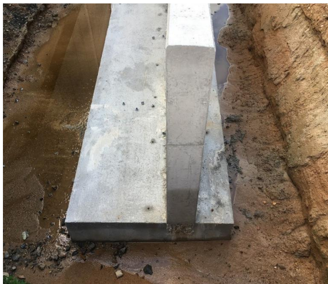
Obrázek 10 - Opěrná stěna s monolitickou patou [zdroj vlastní]
