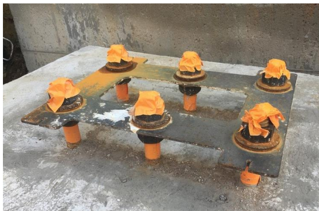
Obrázek 9 - Botka pro uložení sloupu na monolitickou desku [zdroj vlastní]
