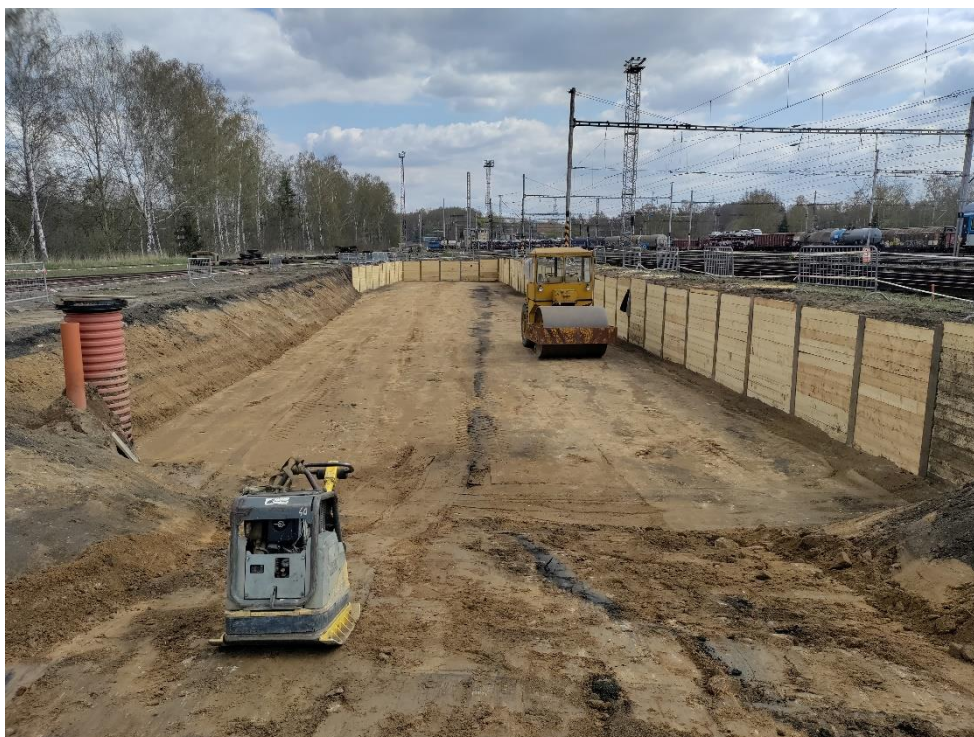
Obrázek 21: Zhutněné dno stavební jámy, foto autor [21]
