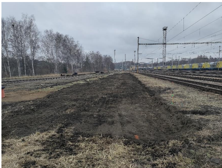
Obrázek 19 : Vytyčení ornice a následná skrývka ornice, foto autor [19]
