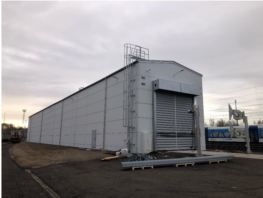
Obrázek 3 : Pohled z příjezdové cesty k S001- Hala myčka vlaků, foto autor [3]
