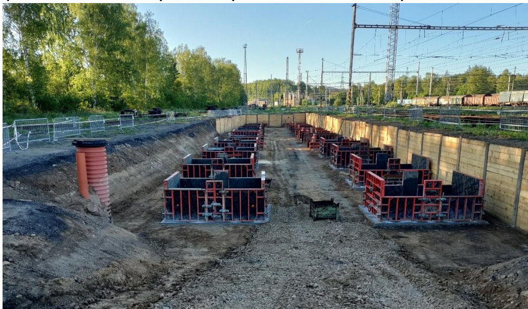
Obrázek 83: Bednění patek, foto autor [83]
