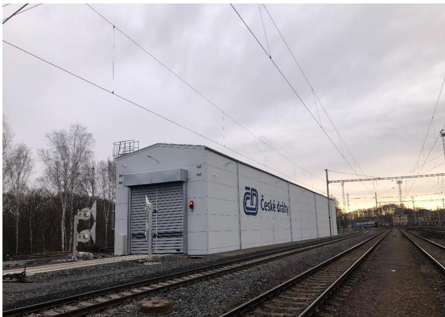
Obrázek 2 : Pohled z kolejiště na S001- Hala myčka vlaků, foto autor [2]
