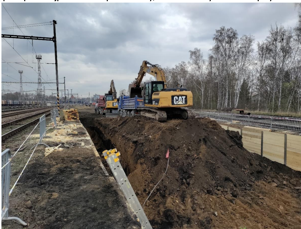
Obrázek 20: Těžení stavební jámy, foto autor [20]
