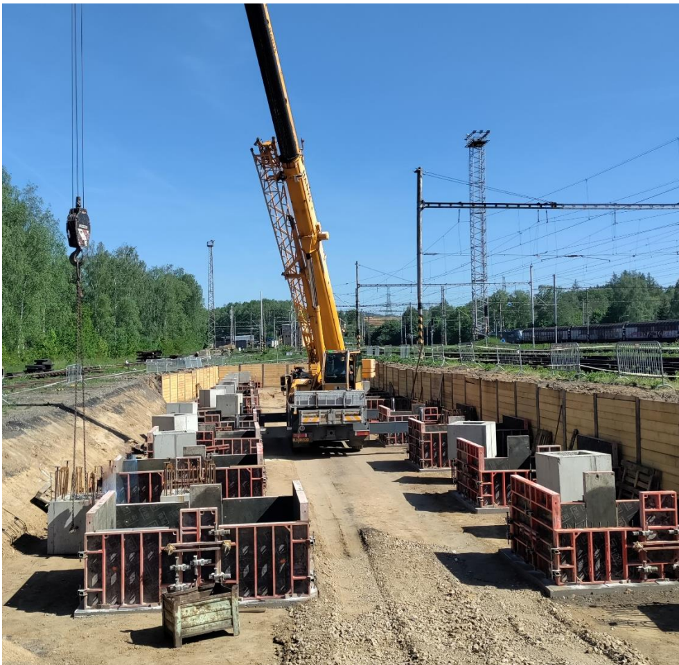
Obrázek 82: Osazování kalichů, foto autor [82]
