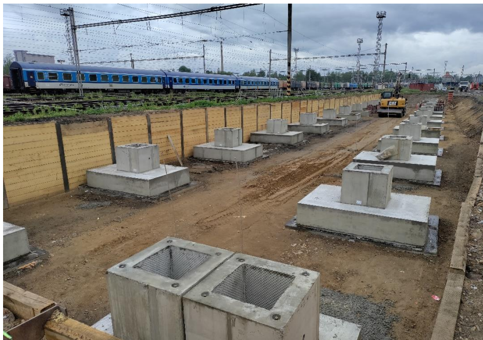
Obrázek 84: Patky po zabetonování a následném odbednění, foto autor [84]
