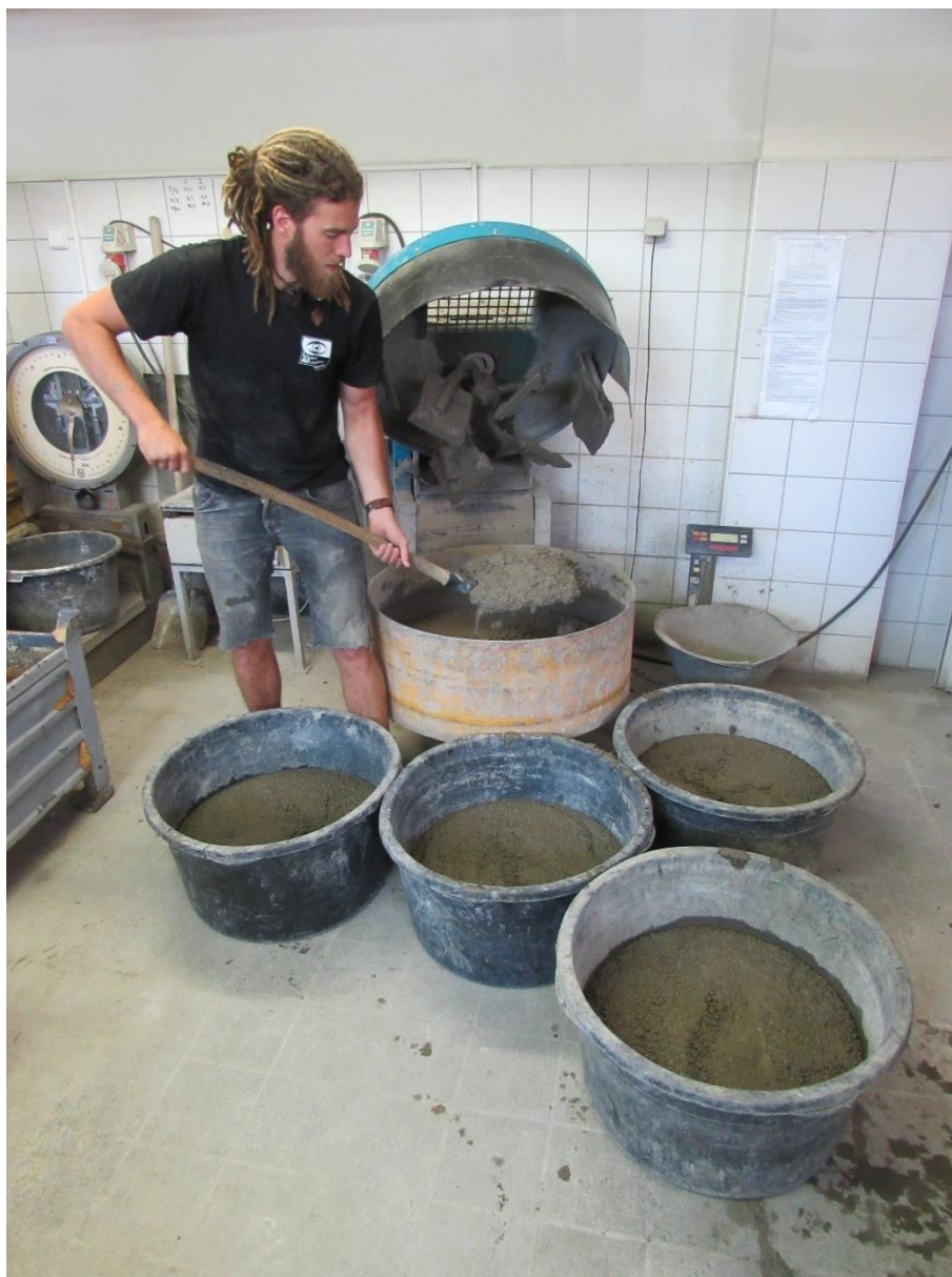
Obr. 12 Výroba čerstvého betonu
