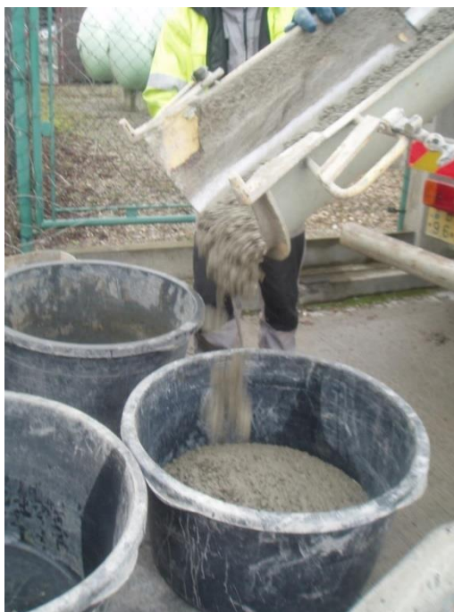
Obr. 15 Přeprava čerstvého betonu
