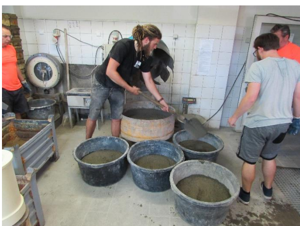
Obr. 126 Míchání čerstvého betonu LB2
