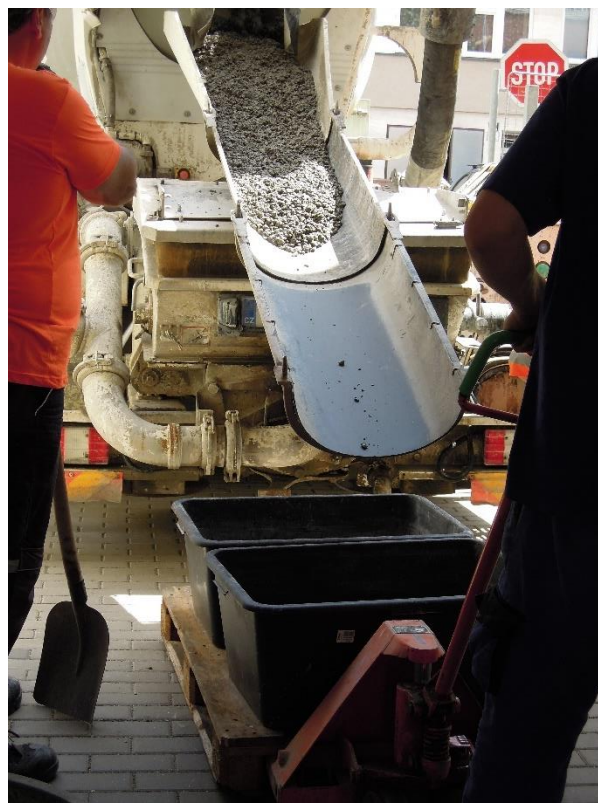
Obr. 135 Transport čerstvého betonu PB2
