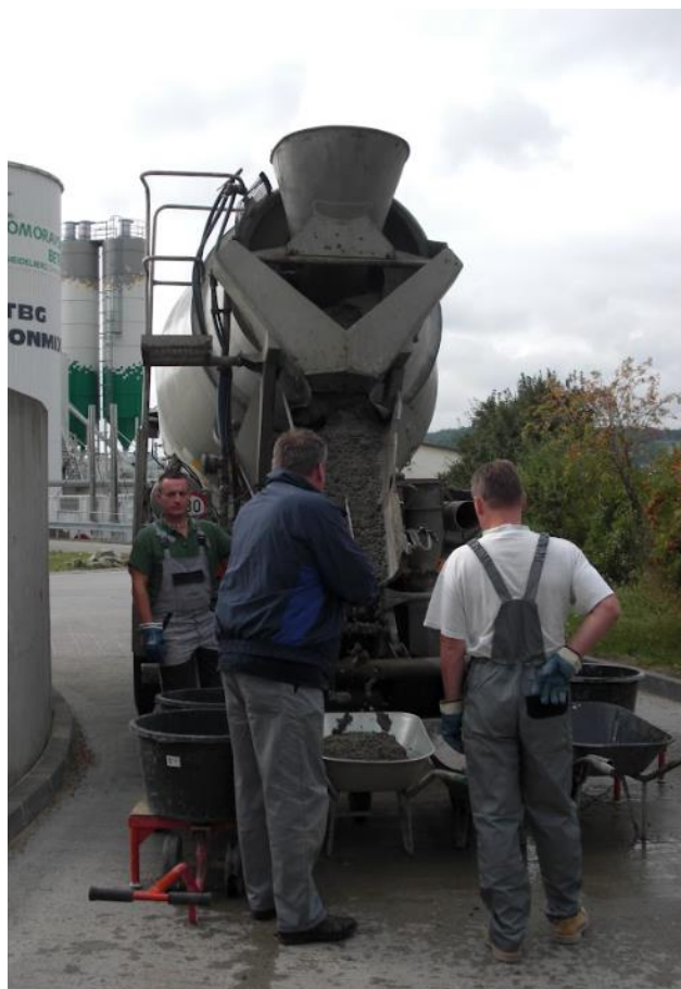
Obr. 13 Transport čerstvého betonu
