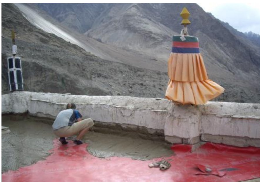
Obrázek 13: Nanášení první ochranné vrstvy na hydroizolaci
