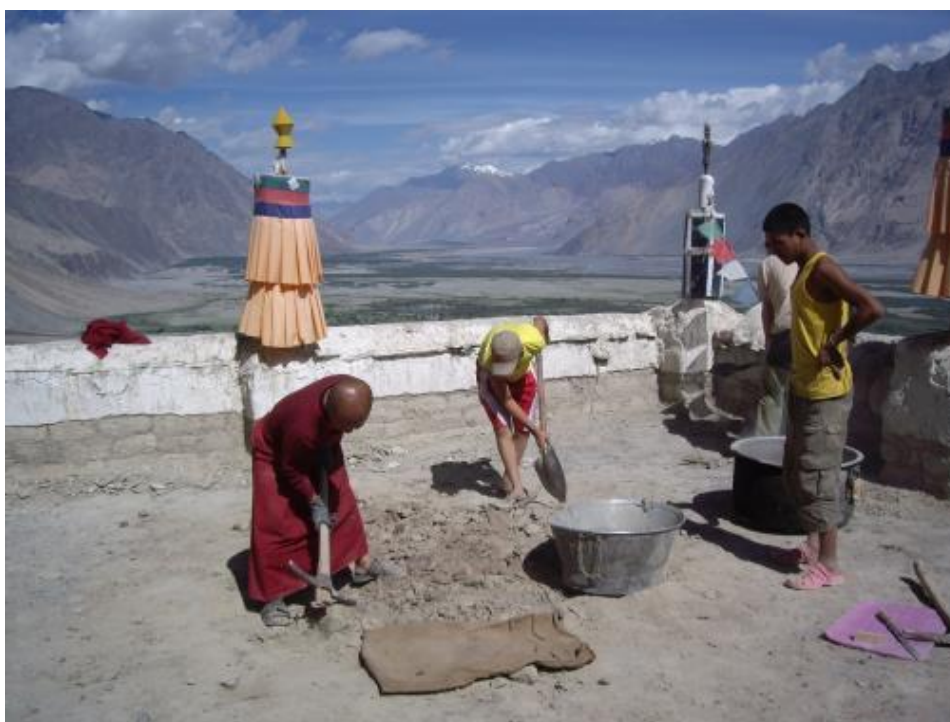
Obrázek 11: Odstranění starého hliněného souvrství
