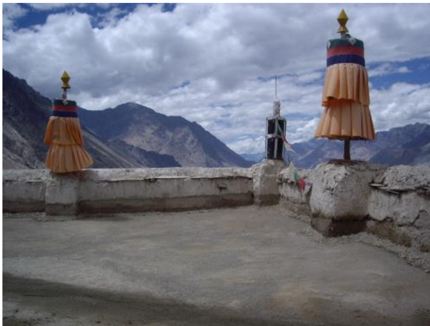
Obrázek 14: Dokončená druhá vrstva včetně posypu jemným kamínkem
